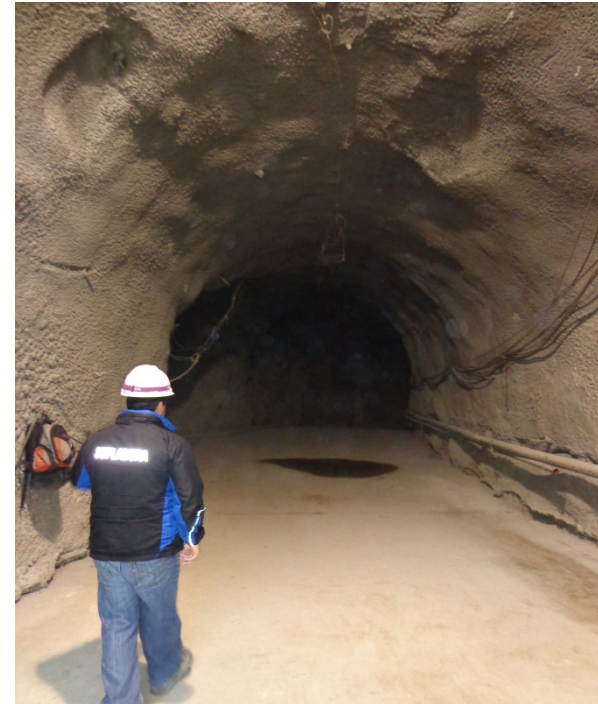
Tunel de Interconexión (captación de las aguas turbinadas de la Central Molino)
