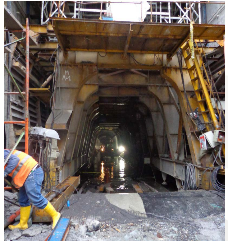
Tunel de descarga
