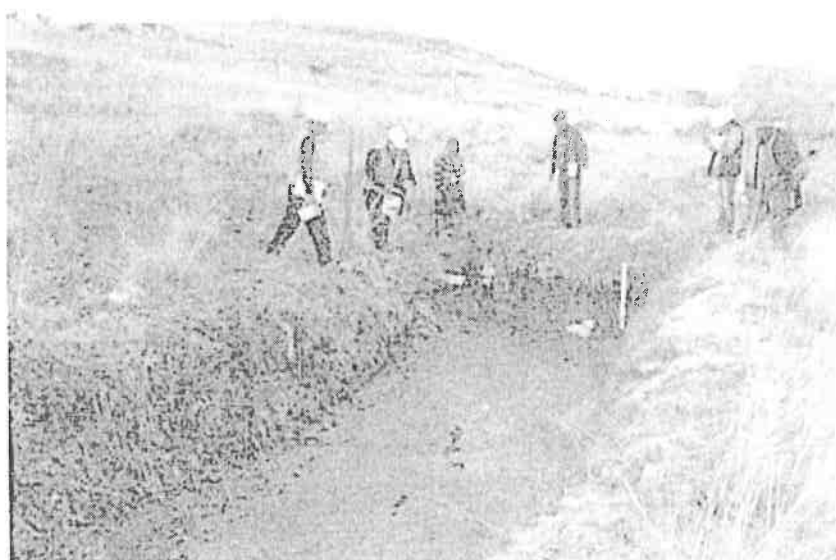
Fig. 4 Zona de filtración de aguas surgentes en terreno de Juan Cansino Cuti, lugar denominado Manante Cuti
