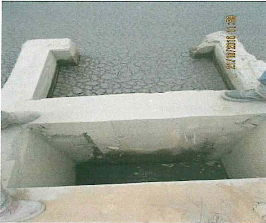
Foto N° 21: La "cámara de rebose" de la poza de evaporación y sedimentación N° 5, se encuentra tapada, sin embargo presenta signos de infiltración en su base y se conecta a través de una tubería de concreto que desemboca al canal principal.
