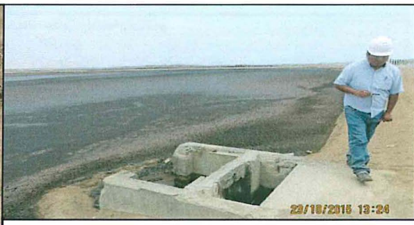
Fotografía 23: Se identifica la existencia de una infraestructura "cámara de rebose" de material noble al interior de la poza de sedimentación y evaporación de licor negro N° 6, que se conecta al otro lado del dique de contención a través de una tubería subterránea a una cámara de concreto cubierta por tierra/arena de función y destino desconocido.
