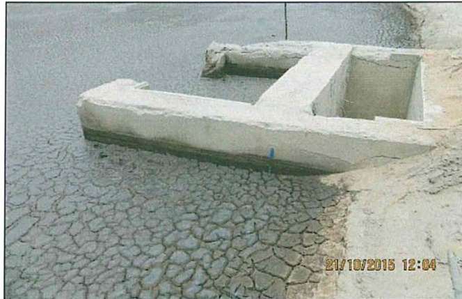
Foto N° 16: Se observa la poza de evaporación y sedimentación N° 5.
