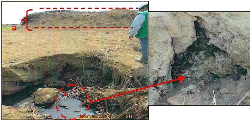
Foto N° 18: Se observa un sector del dique de contención de la poza de evaporación y sedimentación N° 1 cubierto por restos de maleza (a), así como en el corte del canal de conducción de aguas empleadas para el regado de los campos de cultivo de caña de azúcar TRUPAL 1, se observa presencia de licor negro sólido que indicaría infiltración de licor negro (c).
