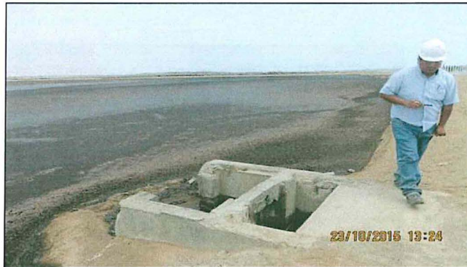
Foto N° 17: Se observa la poza de sedimentación y evaporación de licor negro N° 6.
