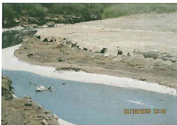
Fotografía 2: En la orilla del punto de descarga así como en la playa de dicho sector se aprecia la presencia de una capa superficial aglomerada a modo de costras formando una lámina superficial apelmazada de material similar a las fibras del bagazo de caña o fibras del proceso de transformación de estas.
