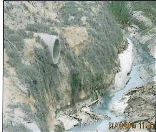
Foto N° 21: La "cámara de rebose" de la poza de evaporación y sedimentación N° 5, se encuentra tapada, sin embargo presenta signos de infiltración en su base y se conecta a través de una tubería de concreto que desemboca al canal principal.
