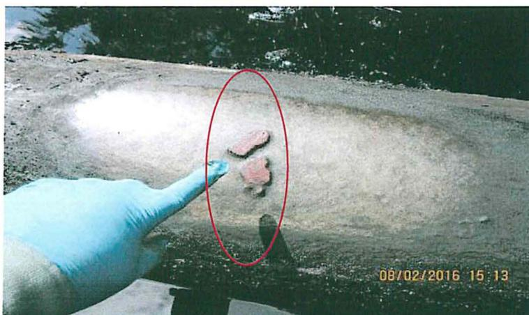
Se muestra el desgaste y/o deterioro que ha sufrido la tubería por efectos de corrosión severa, los dos puntos muestran el estado inicial de la tubería.
