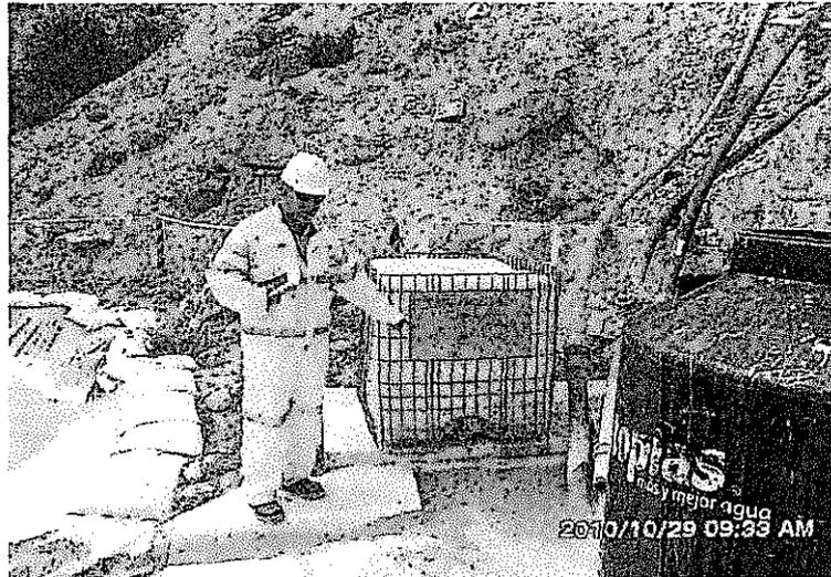
Fotografía N° 13: Dosificación de reactivos en la Planta de Tratamiento Rampa Don Enrique.
