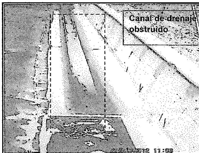
**Fotografía N° 11:** Se observó que en el Área de Facilidades de Llenado de Cisternas, Coordenadas UTM (9448466N 0494268E) el canal de drenaje se encuentra obstruido.
