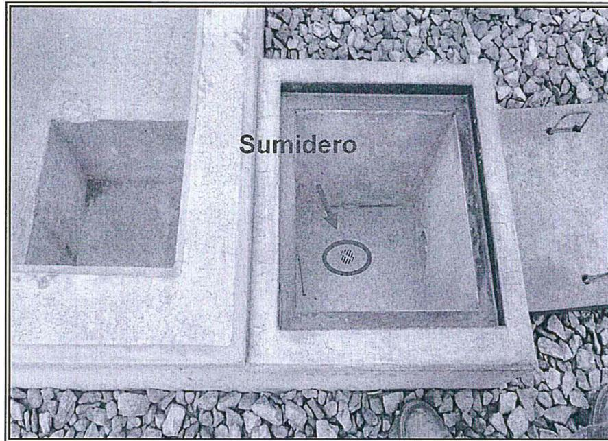
Vistas 3, 4 y 5. Sistema de contención para el tanque de combustible que suministra al grupo electrógeno de la S.E. Planicie, se observa una caja de concreto interconectada con el sistema de contención y tiene un sumidero donde el fluido se infiltraría al subsuelo en caso de derrame, contaminando al medio ambiente.
