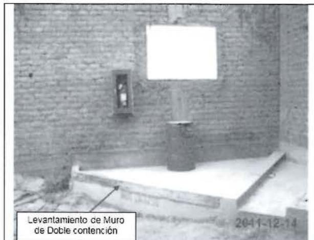
**Fotografía N° 4:** El Almacenamiento Temporal de Residuos Sólidos de la Planta ha sido cerrado y cercado para evitar la contaminación ambiental del suelo.
