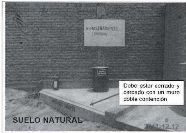
**Fotografía N° 1:** El Almacenamiento Temporal de Residuos Sólidos de la Planta Envasadora de GLP., no está cerrado y cercado con un Sistema de doble contención para evitar la contaminación ambiental del suelo.
