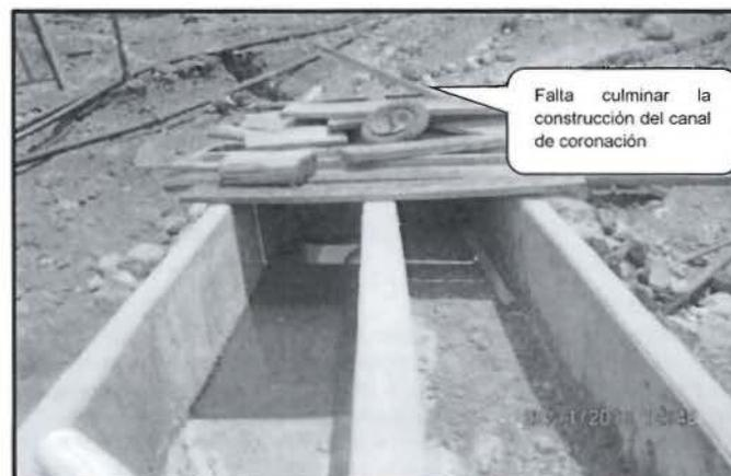
**Fotografía N° 53.-** El canal para captar las aguas de escorrentía de la Quebrada Salomón, falta terminar su construcción.
