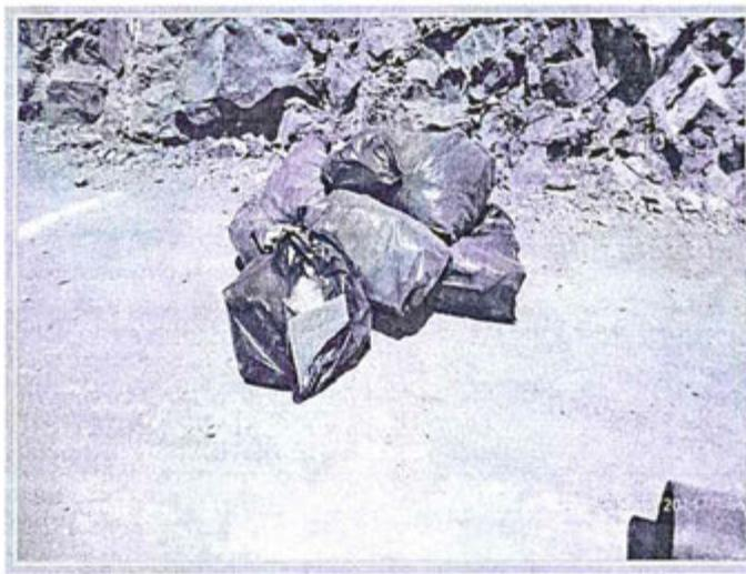
"Fotografía N° 8: Inadecuada disposición de los residuos sólidos industriales peligrosos y no peligrosos en el área industrial en construcción, los residuos sólidos se ubican fuera de los contenedores y en recipientes inadecuados (bolsas plásticas), Recomendación N° 4, UM Pucamarca, 2011".
