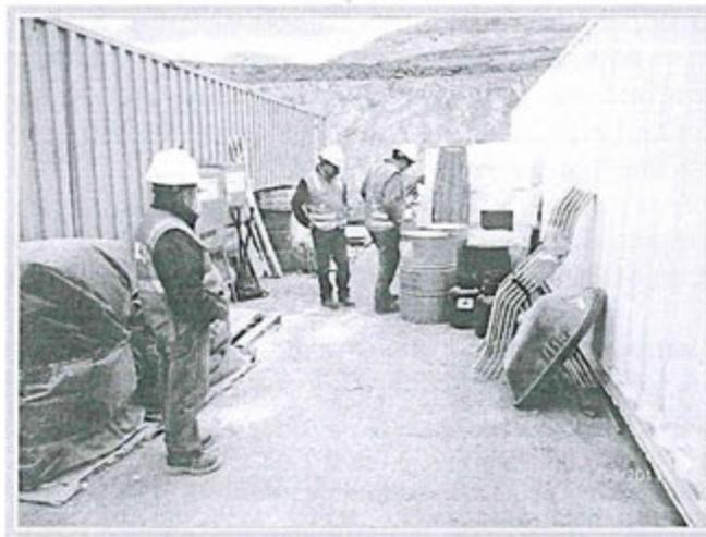
Fotografía N° 5: Inadecuada disposición y almacenamiento de sustancias tóxicas y peligrosas (aditivos y gas licuado de petróleo) directamente sobre el suelo natural a nivel del almacén de la contratista Consorcio Cosapi - Aesa, Recomendación N° 3, UM Pucamarca, 2011. (Subrayado agregado)
