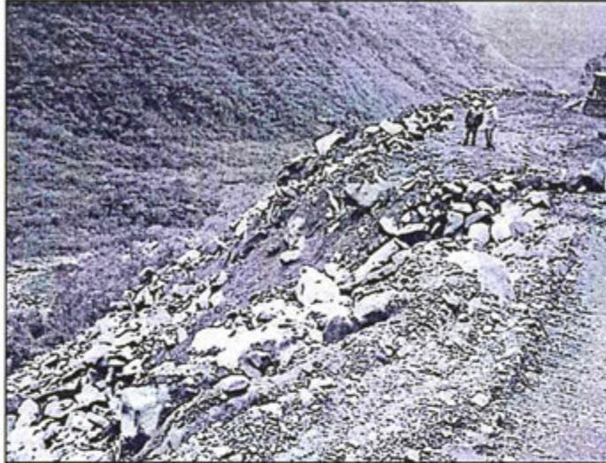
*Foto N°6: Material excedente generado en la construcción de la carretera de acceso ha sido dispuesto sobre la vegetación natural de la rívera del río Chiamayo generando inestabilidad de talud.*
