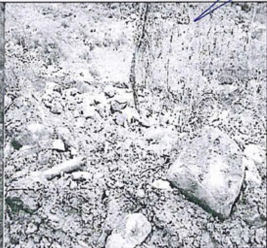
*Foto N°5: Material excedente generado en la construcción de la carretera de acceso ha sido dispuesto sobre la vegetación natural de la rivera del río Chiamayo, generando inestabilidad de talud.*
