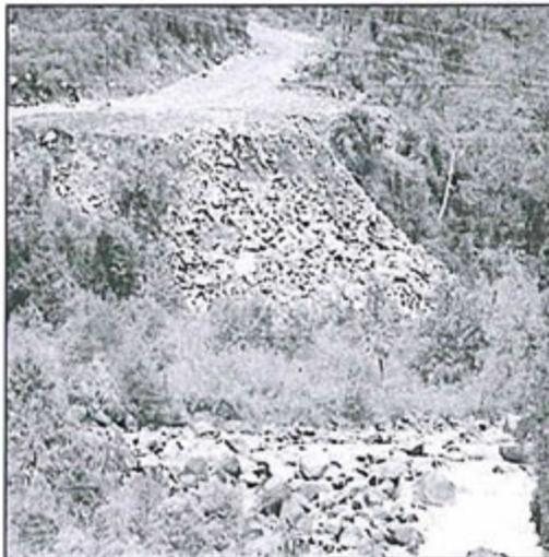
*Foto N°4: Material excedente dispuesto sobre vegetación natural de la rivera del río Chiamayo, generado en la construcción de la carretera para acceso a la zonas del proyecto de las Centrales Hidroeléctricas Ángel I, Ángel II y Ángel III.*
