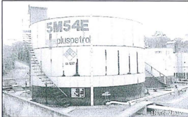
**Fotografía N° 14.-** Vista del área estanca del tanque de almacenamiento 54 de la Batería N° 9, se observa que el área no está impermeabilizada y presenta cobertura vegetal.
