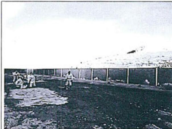
Fotografía N° 17: Conformación en capas con adición de cal en el depósito temporal de Relave Cianurado.
