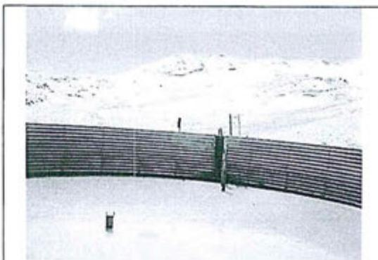
Fotografía N° 11: Tubería metálica de 4" Ø instalada para control del nivel del agua.
