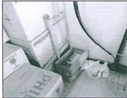
Vistas 2. Cajas de fluorescentes y reactores en desuso dentro de la sala de control
