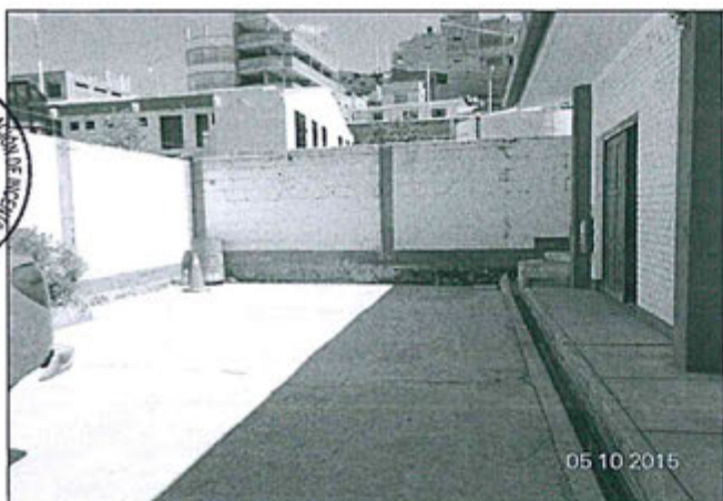
Patio del Lado Izquierdo de la Sub Estación Bellavista - Puno
