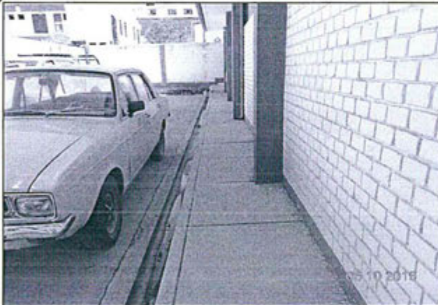
Pasadizos Externos de La Sub Estación Bellavista - Puno
