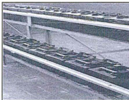
Vista Fotografía N° 13 SE POMATA-Sala de Baterías, nótese la ausencia de baterías fuera de uso
