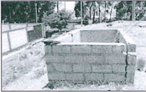
Vistas 1: Poza de residuos sólidos a las afueras del la SET
