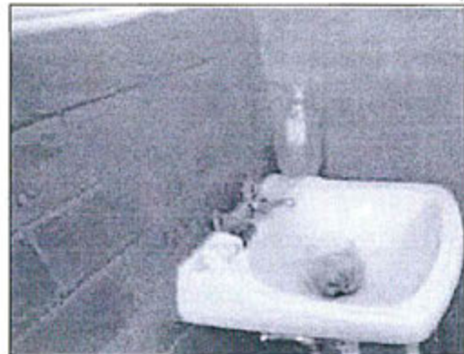
Vista 2: Sala de batería con botellas de plástico en desuso
