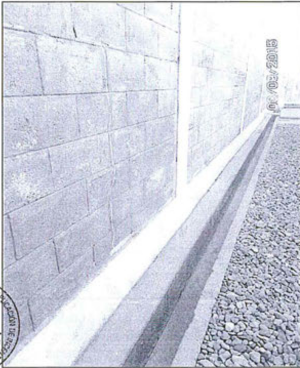
CANALETAS PERIMETRO EXTERIOR DE LA - SET ILAVE
