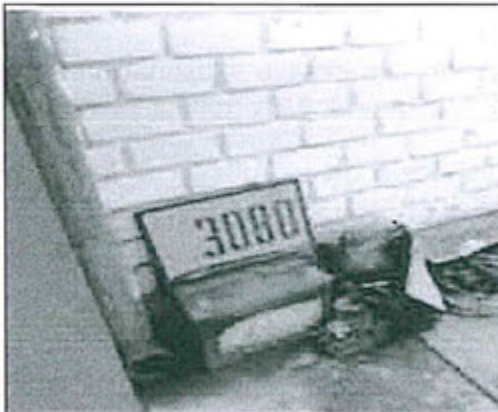
Vistas 3: Batería en desuso en la vereda de la SET
