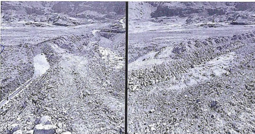
**Fotografía N° 7.- Observación 7, supervisión 2011:** El talud de pie del Depósito de desmontes E-1 en la unidad Reliquias, entre las coordenadas UTM WGS-84, N:8539780, E: 473425, se encuentra en contacto con aguas naturales de filtración.
