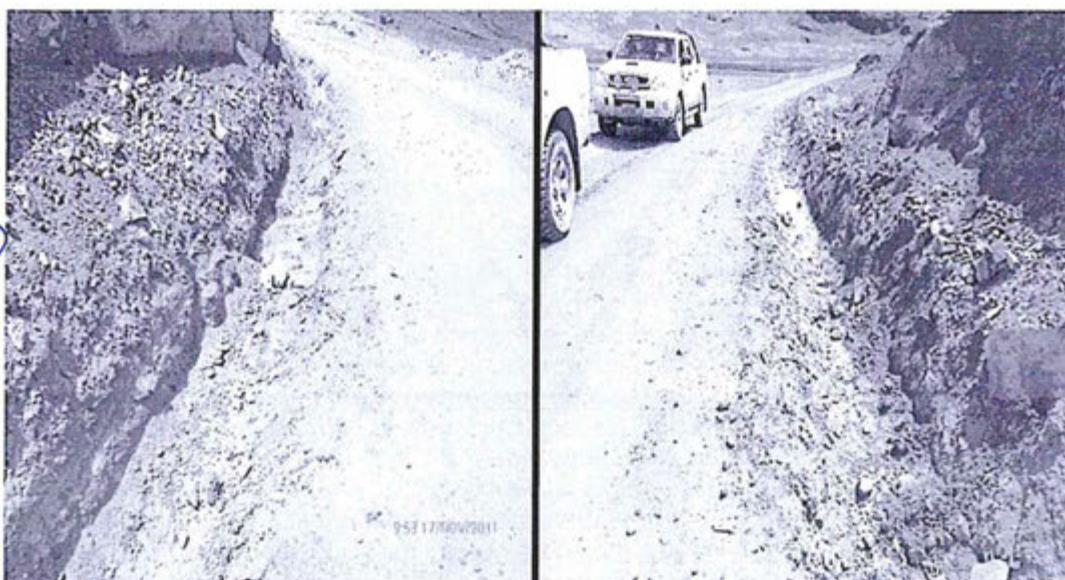
**Fotografía N° 11.- Observación 11, supervisión 2011:** Las carreteras de acceso hacia la unidad Reliquias así como a la unidad Caudalosa Grande cuentan en gran parte con cunetas para aguas de precipitación sin embargo no cuentan en algunos casos con alcantarillas debidamente construidas para derivar las aguas a su ambiente natural, caso del sector entre las coordendas UTM WGS-84 N: 8539814 y E: 472786.
