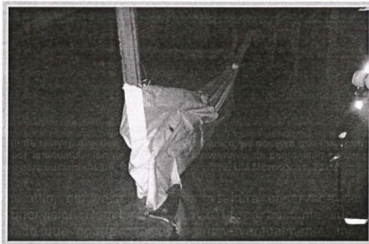
Fotografía N° 32: Depósito de relaves *overflow* para relleno hidráulico, se observa que los muros de contención han sido sobrepasados por la acumulación de relave y se utiliza malla arpillera para su contención con el consecuente impacto al suelo, Recomendación N° 12, UM Morococha, 2011.
