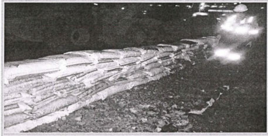
Fotografía N° 2: El titular no ha cumplido con construir el muro de contención de los relaves para relleno hidráulico, se observa que los mismos sobrepasan en altura al muro con el consiguiente riesgo de impacto al suelo, implementación de recomendación Supervisión Especial N° 3 - 2010, UM Morococha, 2011.
