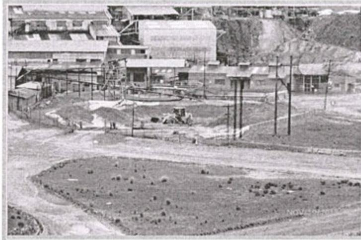
Fotografía N° 30: Depósito de relaves *overflow* para relleno hidráulico, se observa que los muros de contención han sido sobrepasados por la acumulación de relave y se tiene muros de contención construidos con sacos metaleros llenos de relave para su contención, Recomendación N° 12, UM Morococha, 2011.
