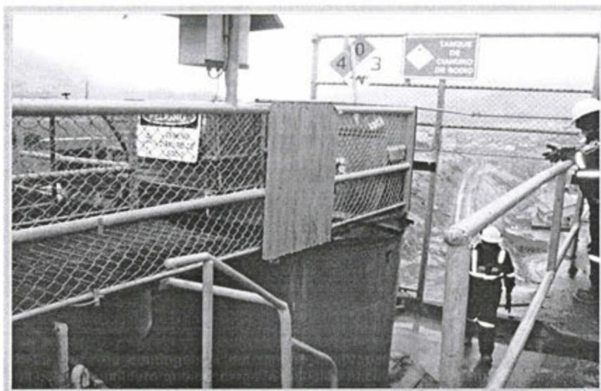
Fotografía N° 9: La poza de contingencia del tanque de preparación de cianuro en Planta Concentradora Amistad cuenta con un sumidero que descarga la solución hacia el medio natural impactándolo directamente, Recomendación N° 4, UM Morococha, 2011.
