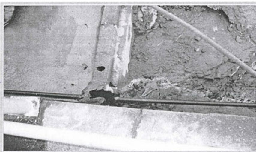
Fotografía N°10: La poza de contingencia del tanque de preparación de cianuro en Planta Concentradora "Amistad" cuenta con un sumidero que descarga la solución hacia el medio natural impactándolo directamente, Recomendación N° 4, UM Morococha, 2011.
