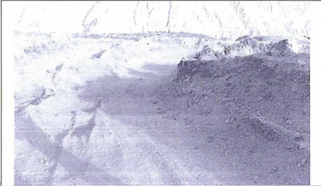
Fotografía N° 13: ANP Aguada Blanca-Salinas. Sección del camino de acceso, se evidencia el enterramiento de la vegetación aledaña, alteración de la superficie y proceso erosivo del suelo.
