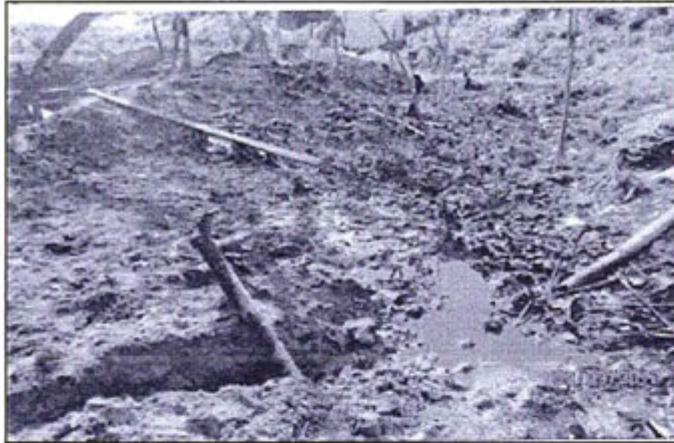
Se aprecia un lugar colindante al área del derrame, donde se observa suelo contaminado con hidrocarburo en un área aproximadamente de 20 m<sup>2</sup>. Asimismo se señala una canaleta de evacuación del hidrocarburo, el mismo que discurre hacia abajo, lugar donde se vienen realizando las actividades de recojo, Coordenadas 815916E y 9454894N.
