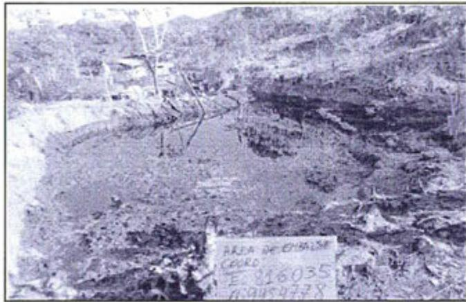
El hidrocarburo derramado ha sido evacuado hacia la parte baja (Tramo I), para la cual se construyó una primera zona de embalse para tratar de evitar que el hidrocarburo siga el curso de la pendiente. Esta primera zona de embalse se ha construido en un área colindante a la carretera, ubicado en las coordenadas 816035E y 9454778N.
