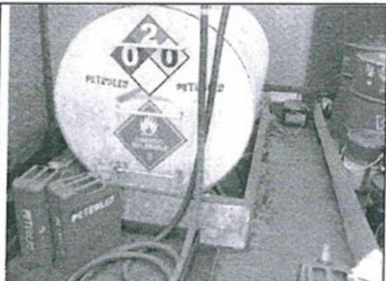
**Vista 26.** El tanque diesel no cuenta con un adecuado sistema de contención que evite posibles derrames de hidrocarburos.
