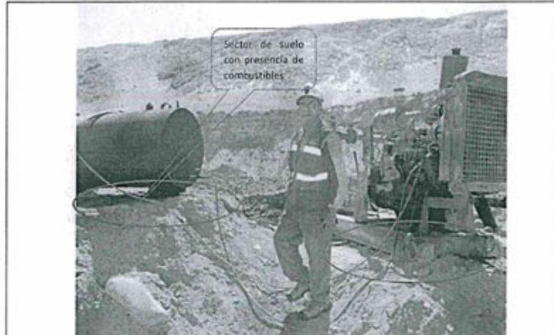
Fotografía N° 78.- HALLAZGO N° 02: Ubicación de tanque de combustible y grupo electrógeno en un sector de la poza de sedimentación C, directamente en el suelo sin ningún tipo de sistema de contención en caso de derrames, se verificó derrames de combustible en el suelo.
