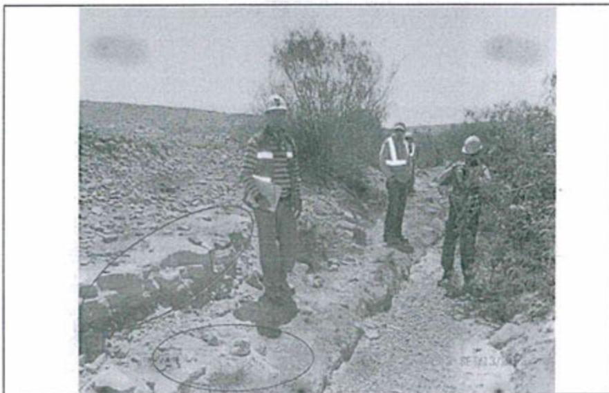
Fotografía N° 95.- HALLAZGO 08: En el cauce seco de Quebrada Honda se verificó acumulación de sedimentos de relaves (círculos rojos) que eran conducidos por dicho cauce antes de que el titular minero construya el Embalse de Relaves Quebrada Honda.
