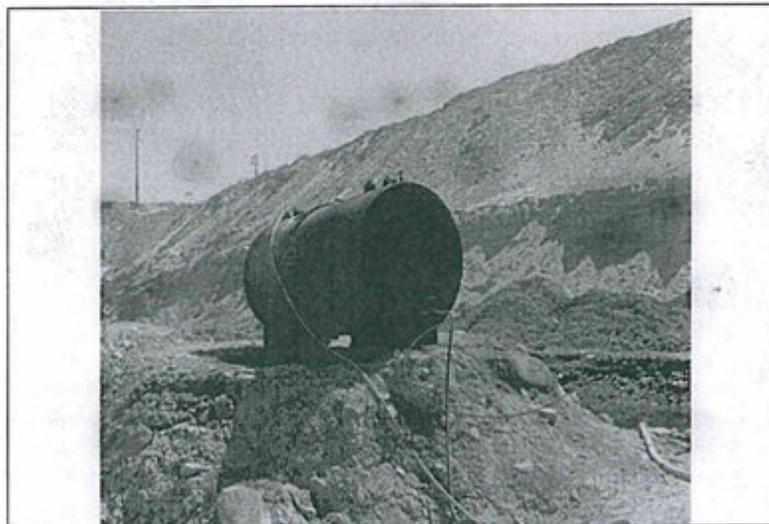
Fotografía N° 80.- HALLAZGO N° 02: Tanque de combustible sin bandeja de contención en caso de derrames, se observa suelo afectado con dicha sustancia peligrosa (círculo rojo).
