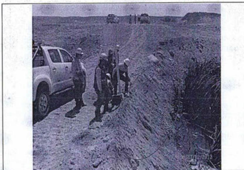
Fotografía N° 84.- HALLAZGO 04: Falta de acceso para tomar muestras de agua en el punto de monitoreo PD-PR proveniente de la poza de sedimentación y filtración de aguas del embalse de relaves Quebrada Honda. Por dicha dificultad se tomó la muestra aguas abajo.
