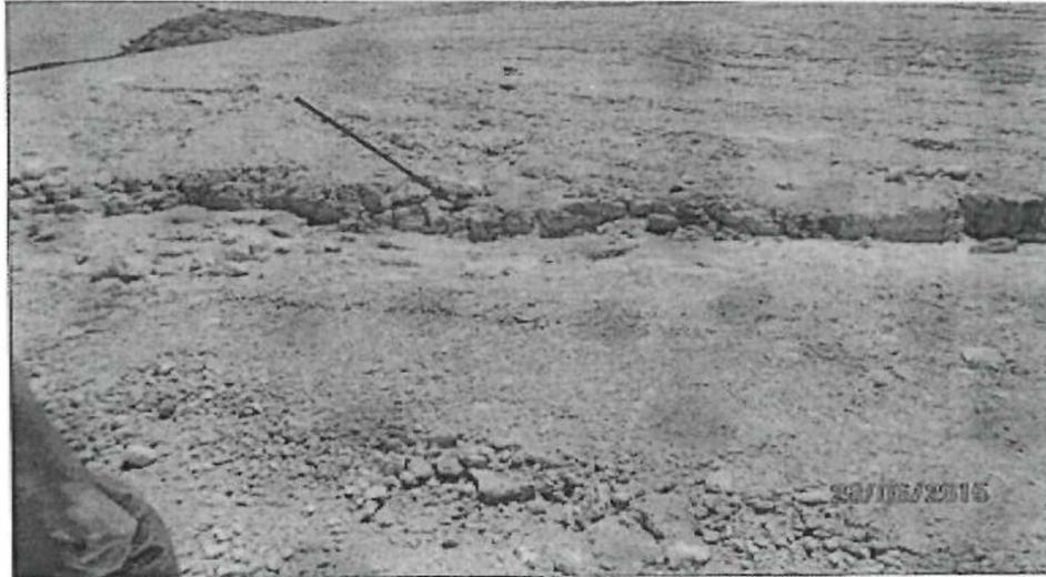
Foto N°04: Canal de coronación de la Cantera de puzolana Sexi, que el administrado implementó para la conducción de las aguas pluviales.
