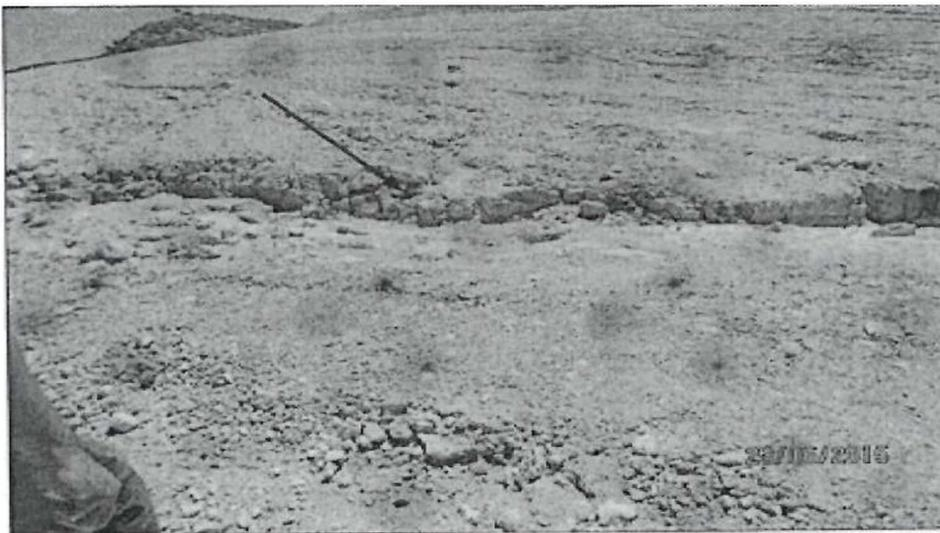
Foto N°04: Canal de coronación de la Cantera de puzolana Sexi, que el administrado implementó para la conducción de las aguas pluviales.
