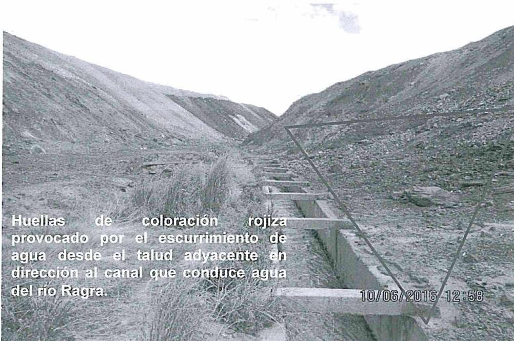
Huellas de coloración rojiza provocado por el escurrimiento de agua desde el talud adyacente en dirección al canal que conduce agua del río Ragra.
