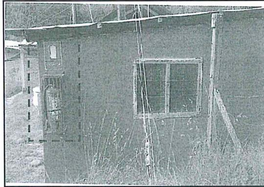
28. En la imagen precedente se aprecia la implementación de un sistema contra incendios (extintor), el extintor de polvo químico seco se encuentra en la parte externa del almacén y cuenta con señalización.
