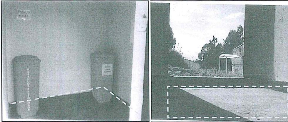
24. Conforme a lo indicado por el administrado y de lo observado en las fotografías, el piso del almacén central es de cemento pulido. Cabe señalar que el cemento es un material resistente y la práctica de pulirlo lo hace liso; por lo tanto, el piso del almacén central para el acopio de residuos sólidos peligrosos es resistente, liso e impermeable. De otro lado, señala que almacenará un volumen máximo de 200 litros por año de aceite.
