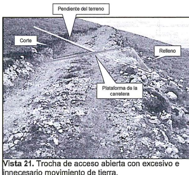
72. El material colocado como relleno se considera como un material inestable toda vez que su contacto con diversos agentes externos (viento, precipitación, movimientos sísmicos, entre otros) provoca que este material se desplace hacia la pendiente produciéndose deslizamientos<sup>37</sup>.
