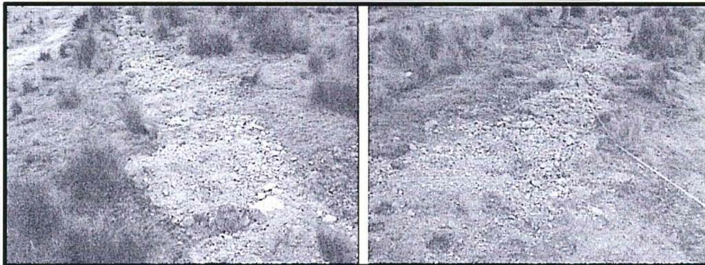
Vista 13. Zanjas de infiltración, cerca de la torres N° 153, cubiertas de material extraído.
