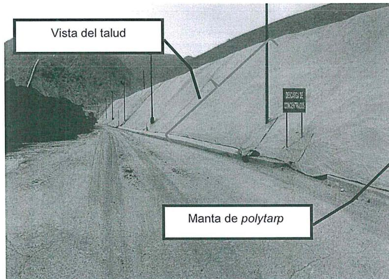
Fotografía N° 4: Manta de impermeabilización colocada al 100% (Coordenadas UTM WGS 295 079 Este; 8 676 279 Norte)
