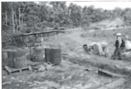
**Situación inicial:** Quince cilindros con metanol sobre un área con geomembrana en un área sin impermeabilizar y sin sistema de doble contención.
