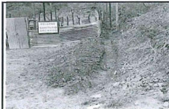
Se puede apreciar un canal existente que hace que las aguas de escorrentía sean derivadas a no permitiendo su ingreso al relleno.
