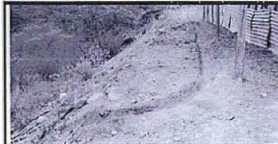
Se aprecia otro canal para derivar las aguas de escorrentía evitando su ingreso al relleno
