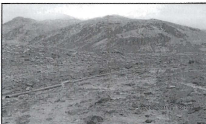
Fotografía N°3. Se observa la tubería de 4", instalada para la conducción y traslado de las aguas de la zona observada, entre el Tajo Valle Este y el Depósito de Desmonte N°3.
