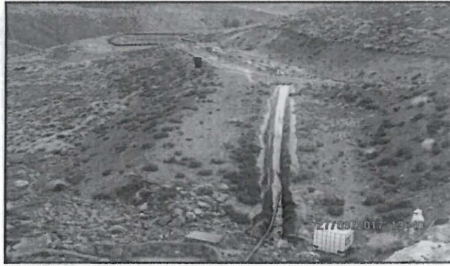
Fotografía N°8. Se observa la tubería de 4" en mención, la misma que tiene como fin conectar al canal de derivación de subdrenaje del Botadero N°3, el cual se deriva asimismo al sistema de tratamiento de aguas ácidas.
