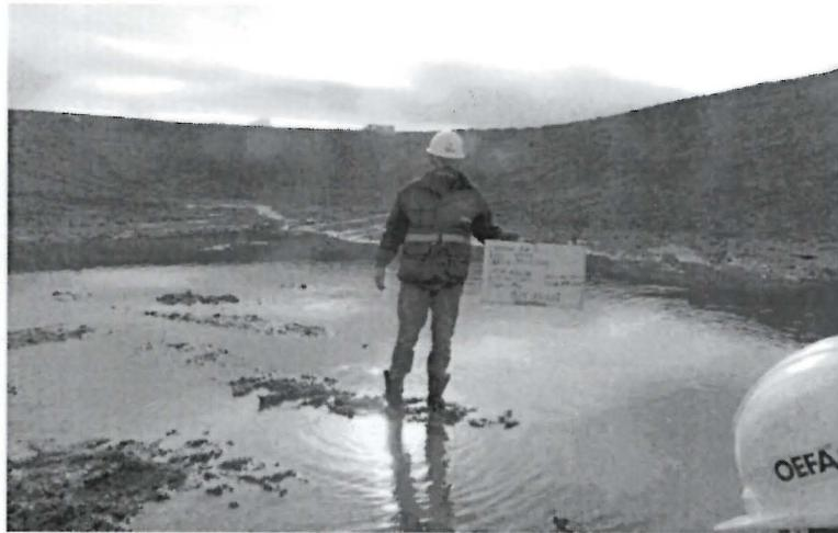
Fotografía N° 7: Acumulación de agua ácida entre el tajo Valle y el depósito de desmonte N° 3. Se observa el letrero de identificación del punto de monitoreo especial EW-7.
