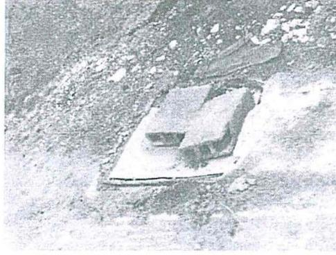
En la fotografía N° 2, se observa la tapa externa de metal del tanque N° 6, el mismo que ya ha sido enarenado.
