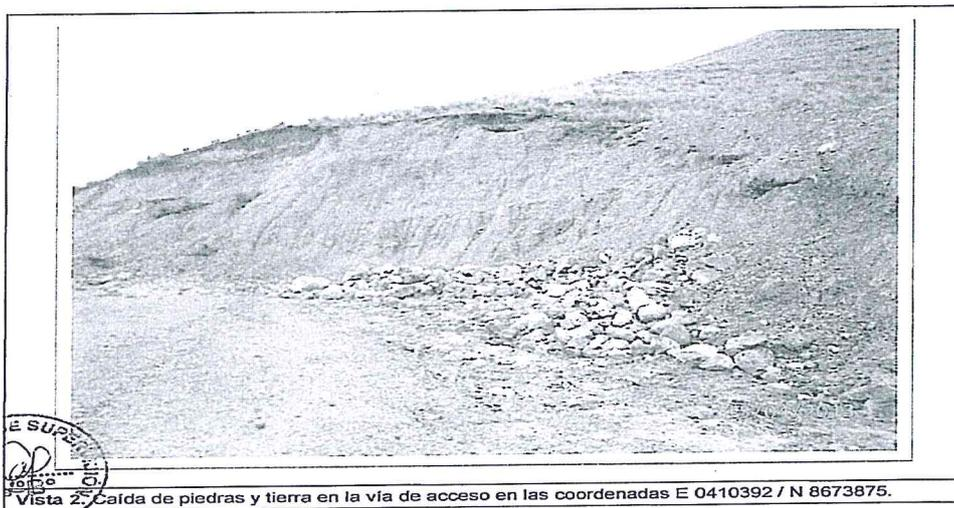
68. En efecto, de acuerdo con el Informe de Supervisión citado líneas arriba, los taludes del camino de acceso se encontraban inestables, lo cual se confirmó con el desmoronamiento de la tierra y rocas sobre las vías; asimismo, en dichos tramos los taludes no presentaban ninguna medida de estabilización.
