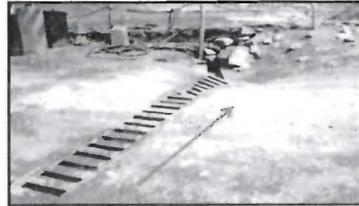
**OBSERVACION 3:** El tramo de la vía de acceso del túnel Santa Ana hacia la plataforma de almacenamiento de minerales de Planta Concentradora, no cuenta con una cuneta que permita conducir y derivar el agua de escorrentía que está afectando dicha plataforma de almacenamiento de mineral, y se observa acumulación de agua de escorrentía que es descargada aguas abajo sobre el talud de suelo y acumulación de desmontes causando riesgos de infiltración de agua con contenidos de metales en el suelo.
