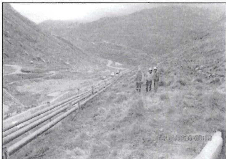
**Fotografía N° 35. Hallazgo 2:** Vista de las tuberías de conducción de relave y el muro de concreto, ante posibles fugas de relave este entraría en contacto directo con el suelo.
