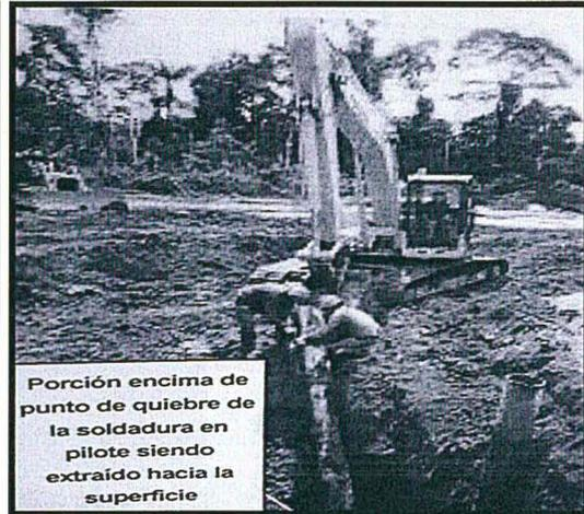
Porción encima de punto de quiebre de la soldadura en pilote siendo extraído hacia la superficie
