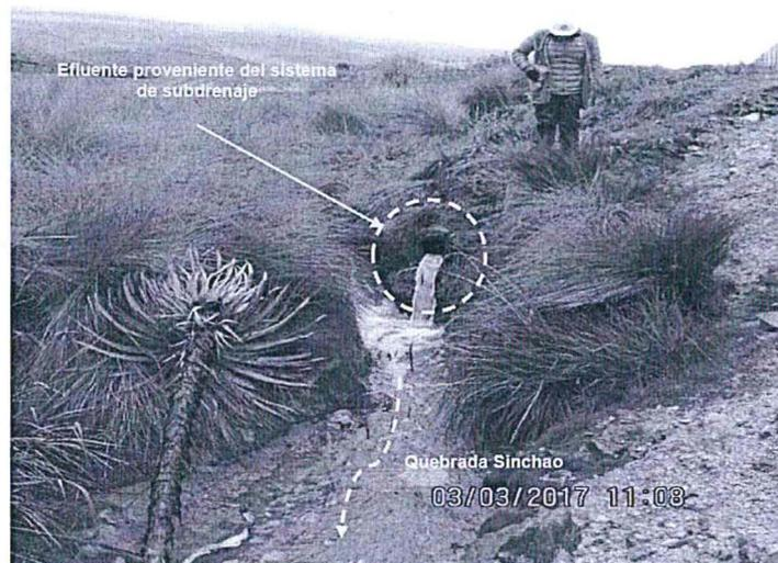
**Fotografía N° 52:** El efluente proveniente del sistema de subdrenaje general estaría siendo descargado mediante una tubería hacia la quebrada Sinchao, sin tratamiento previo y con un pH de 2,02.
