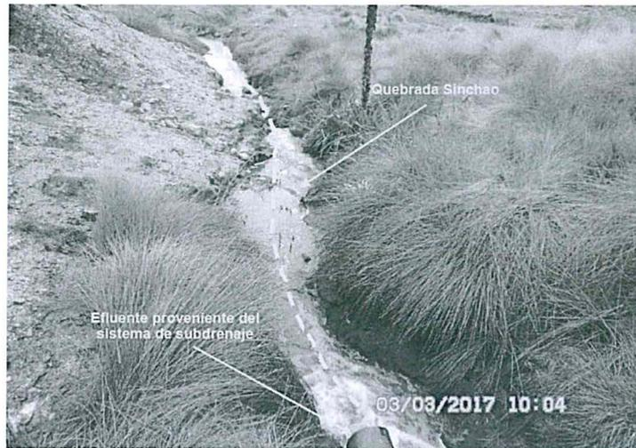
Fotografía N° 53: El efluente proveniente del sistema de subdrenaje general estaría siendo descargado mediante una tubería hacia la quebrada Sinchao, sin tratamiento previo y con un pH de 2,02.
