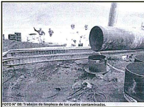
FOTO N° 08: Trabajos de limpieza de los suelos contaminados. En el fondo de la foto se observa el recojo de suelos contaminados con hidrocarburos por el personal del administrado.
