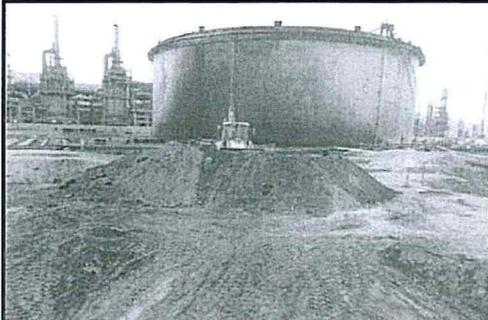
FOTO N° 12: Suelos con hidrocarburos dentro del área estancia del grupo de tanques 1D y 1E.
