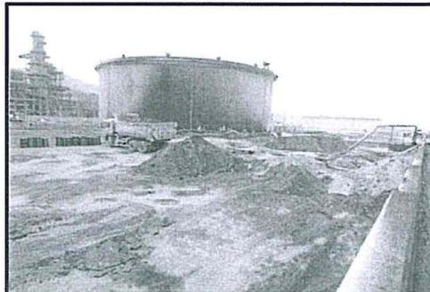
FOTO N° 15: Vista de suelos impactados con hidrocarburos, recojo de los mismos con camiones y tractores.
