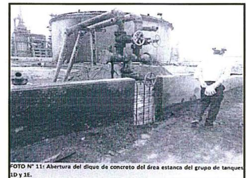
FOTO N° 11: Abertura del dique de concreto del área estanca del grupo de tanques 1D y 1E. En la fotografía se observa la abertura del dique de concreto, a través del cual ingresó los hidrocarburos derramados hacia el área estanca del grupo de tanques 1D y 1E. Asimismo, se observa las válvulas deterioradas como consecuencia del incendio.
