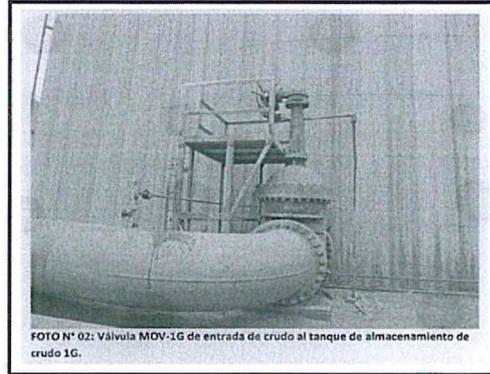
FOTO N° 02: Válvula MOV-1G de entrada de crudo al tanque de almacenamiento de crudo 1G.
