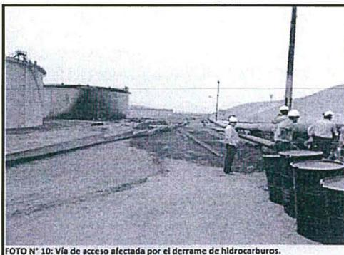
FOTO N° 10: Vía de acceso afectada por el derrame de hidrocarburos. En la fotografía se observa el recorrido del derrame desde el origen por la vía de acceso hacia el área estanca del grupo de tanques 1D y 1E.
