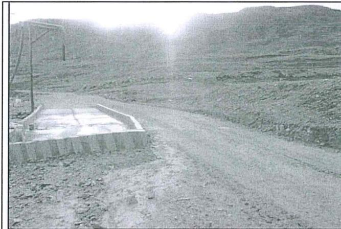
Fotografía N° 2: vista de la losa de maniobra del camión que transporta el lodo hacia el Depósito de Relaves N° 5
