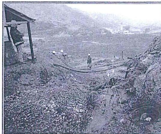
Fotografía N° 89: Se observa el agua que emite la Bocamina B-3, como se dispersa hacia aguas abajo por suelo natural, debido a que no tiene un canal debidamente impermeabilizado que lo dirige hacia su canal de concreto, se dispersa e las coordenadas del lugar UTM (Datum WGS 84) E N8782978,E345154
