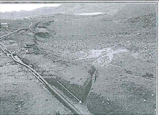
Fotografía N° 49: Hallazgo N° 7, se observa la erosión del talud adyacente al tubo de HDPE 8\"/>
