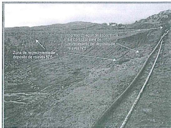
Fotografía N° 48: Hallazgo N° 7. Se observa la zona del recrecimiento de relaves N° 5 recibiendo el agua de escorrentía sin control en todo su lecho de recrecimiento, el ingreso de agua de escorrentía está ubicado en las coordenadas (Datum WGS 84) N8783630, E347051
