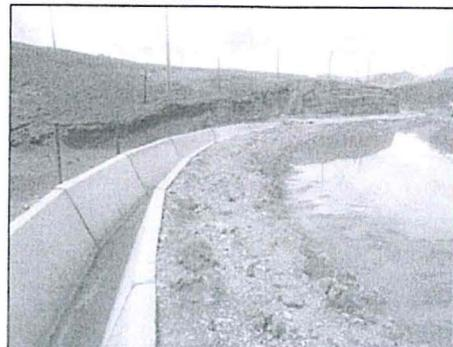
Fotografía N° 6: Canal de coronación perimetral del Depósito de Relaves N° 5
