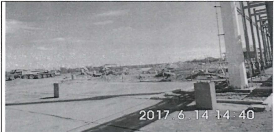
Fotografía N° 14: Trabajos de construcción de bases para la instalación de equipos como tachos, centrifugas, cristalizadores para la producción de azúcar.
