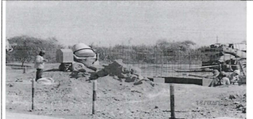
Fotografía N° 13: Vista de trabajos civiles (sobrecimiento) para la instalación de una planta de producción de azúcar de caña, dentro del establecimiento del administrado.
