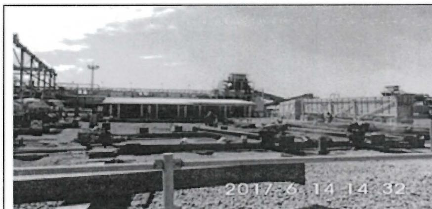
Fotografía N° 15: Trabajos de soldadura para la instalación de estructuras metálicas en la planta de producción de azúcar de caña que viene siendo instalada por el administrado.
