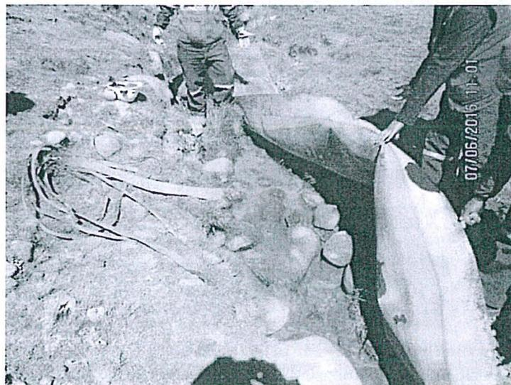
Fotografía N°13. El agua residual de los subdrenajes del depósito de desmontes, vertimiento con código QCH-A discurren por debajo de la geomembrana. Hallazgo N° 1.
