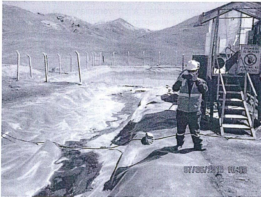
Fotografía N°18. Captación de subdrenajes en canal revestido con geomembrana hacia la poza. Nótese que éstos discurren por debajo de la geomembrana.
