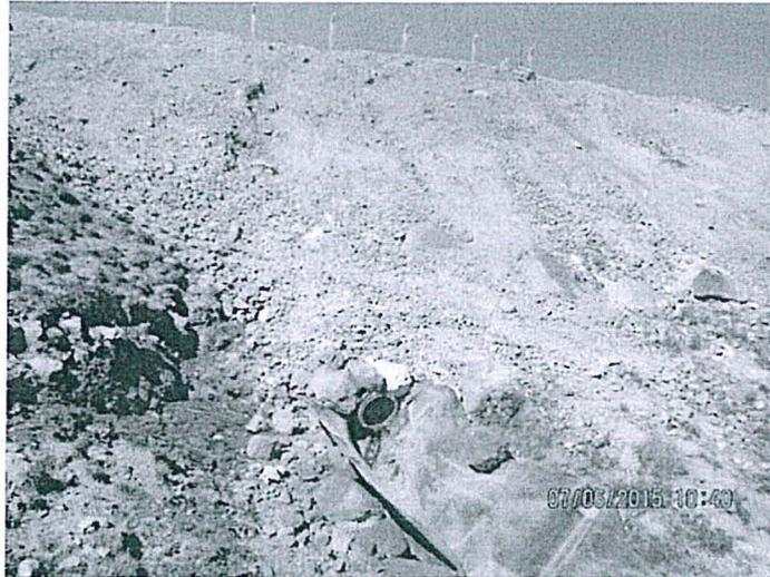
Fotografía N°16. Tubo de descarga de la poza de subdrenajes del depósito de desmontes. No se nota flujo. Hallazgo N° 1.
