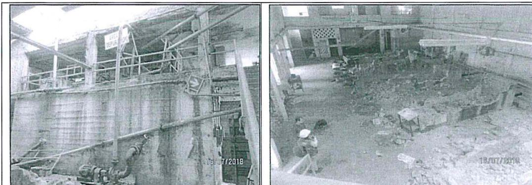
**Fotografía N° 02:** Área de depuración, de material noble con techo de Eternit, se observa desmantelada y fuera de funcionamiento.
