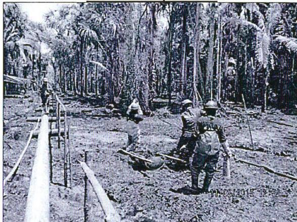
Se observa el recojo de material impregnado con hidrocarburo que luego van a ser depositados en el pit de lavado.
