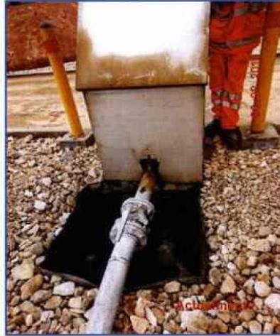
Fotografía N° 08. Estancia en la zona de descarga, se implementó un control adicional: colocación de una bandeja de geomebrana la salida de la tubería
