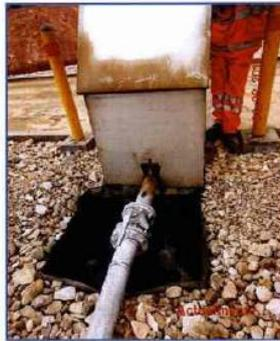
Fotografía N° 08. Estancia en la zona de descarga, se implementó un control adicional: colocación de una bandeja de geomembrana la salida de la tubería
