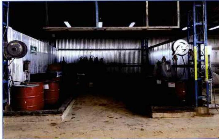
Fotografía N° 06. Sistema de contención de en la zona de manejo y almacenamiento de hidrocarburos.
