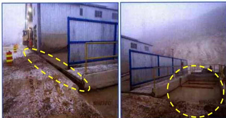
Fotografía N° 05. Se puede notar que el sistema colector ingresa a una poza sedimentadora y posteriormente a una trampa de grasa
