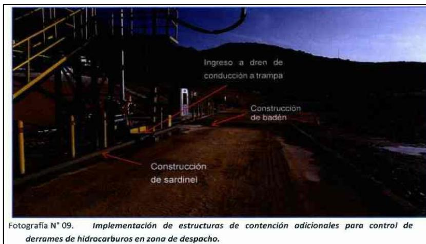
Fotografía N° 09. Implementación de estructuras de contención adicionales para control de derrames de hidrocarburos en zona de despacho.
