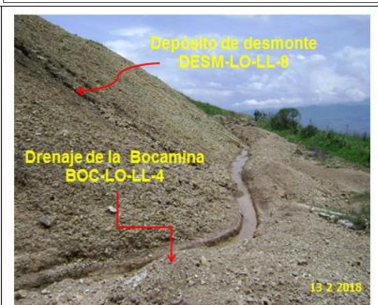
**Fotografía N° 39:** Drenaje de la bocamina BOC-LO-LL-4, que discurre en un segundo tramo por un canal de tierra (tipo zanja), ubicado al pie del talud del depósito de desmonte DESM-LO-LL-8. Se observó deslizamiento del material de desmonte hacia el canal.
