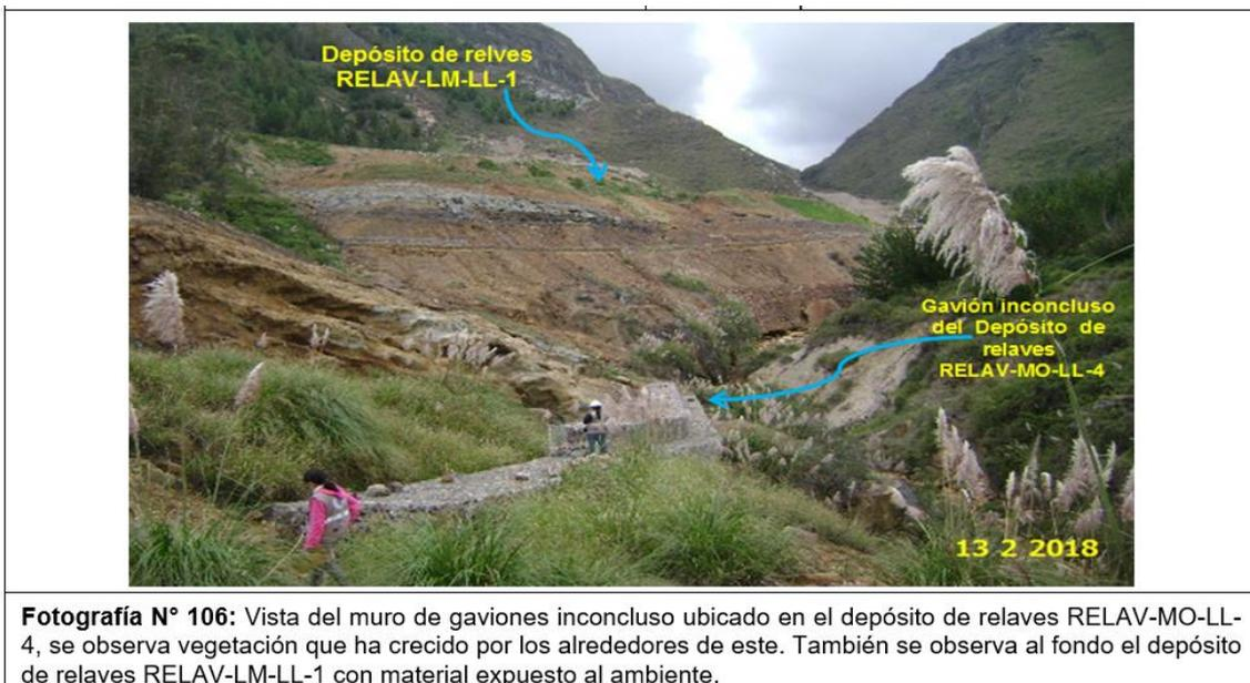
**Fotografía N° 106:** Vista del muro de gaviones inconcluso ubicado en el depósito de relaves RELAV-MO-LL-4, se observa vegetación que ha crecido por los alrededores de este. También se observa al fondo el depósito de relaves RELAV-LM-LL-1 con material expuesto al ambiente.
