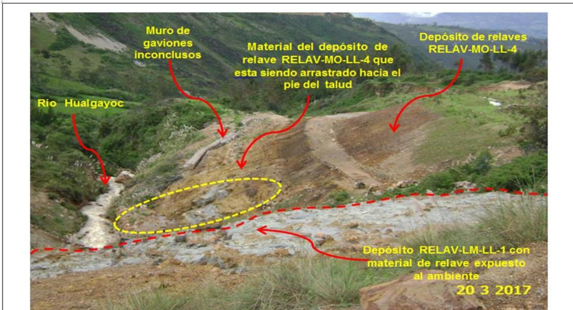
**Fotografía N° 79:** Depósito de relave RELAV-MO-LL-4, ubicado en la margen derecha del río Hualgayoc, con coordenadas (UTM WGS84), N 9253218, E: 766716, cuenta con muro de gaviones inconcluso y banqueta en la parte media del talud de este componente. Además, se observa, que el relave está siendo arrastrado hacia el pie del talud.
