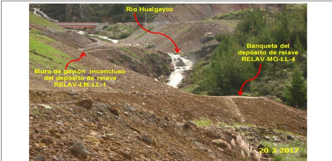
**Fotografía N° 78:** banqueta del depósito de relave RELAV-MO-LL-4, además se observa el muro de gaviones inconcluso ubicado al pie del depósito de relave RELAV-LM-LL-1, se observa su cercanía al río Hualgayoc. Ambos componentes se encuentran en la margen derecha del río Hualgayoc,
