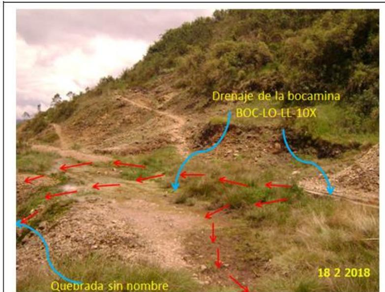
**Fotografía N° 36:** Drenaje de la bocamina BOC-LO-LL-10X, que después de ser conducido por el canal de concreto, luego discurre por la vía de acceso para finalmente descargar a la quebrada sin nombre.
