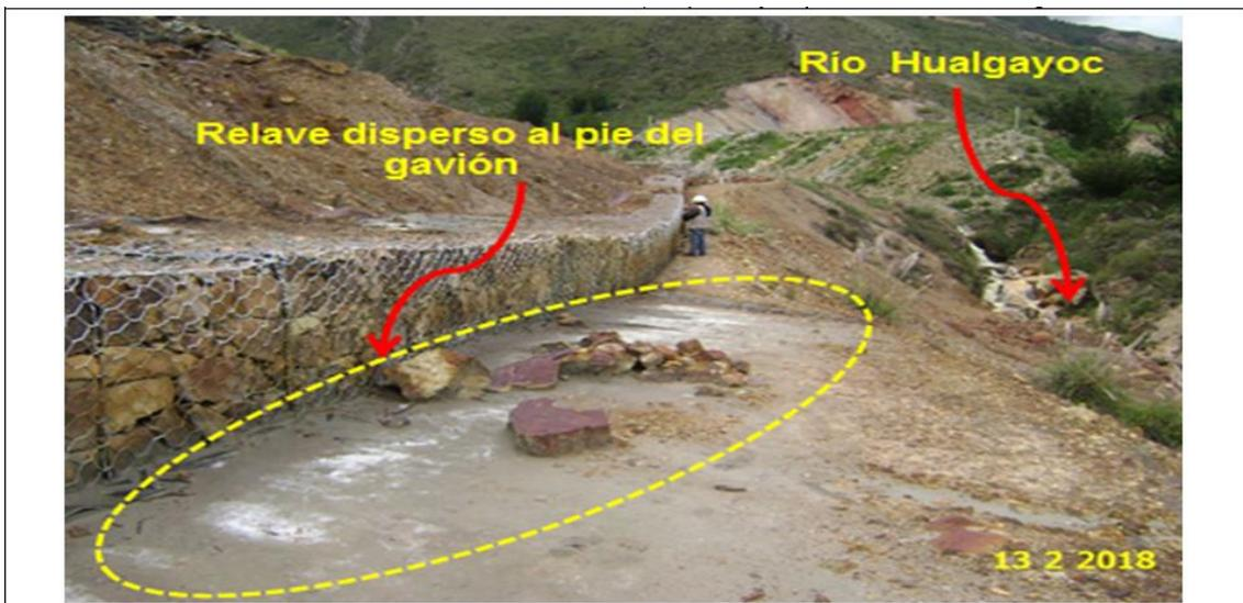
**Fotografía N° 97:** Muro de gaviones del depósito de relave RELAV-LM-LL-1, se observa el material de relave disperso al pie de este muro y su cercanía al río Hualgayoc.
