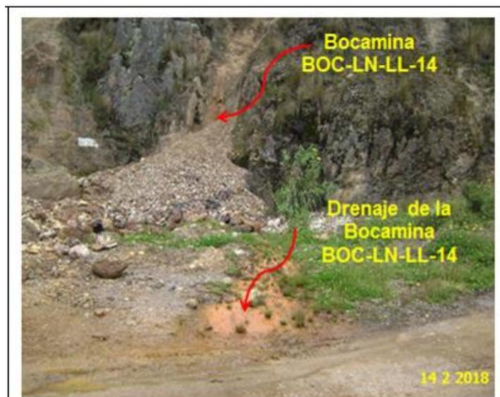
**Fotografía N° 53:** Bocamina BOCLN-LL-14, cuyo portal, ha sido cubierta por acumulación de fragmentos de roca que llega a cubrir parte de la cuneta de drenaje. El drenaje de la bocamina sale tanto por la cuneta, como por el lado inferior derecho, este último, discurre en dirección a la vía de acceso con sedimentos de color naranja.
