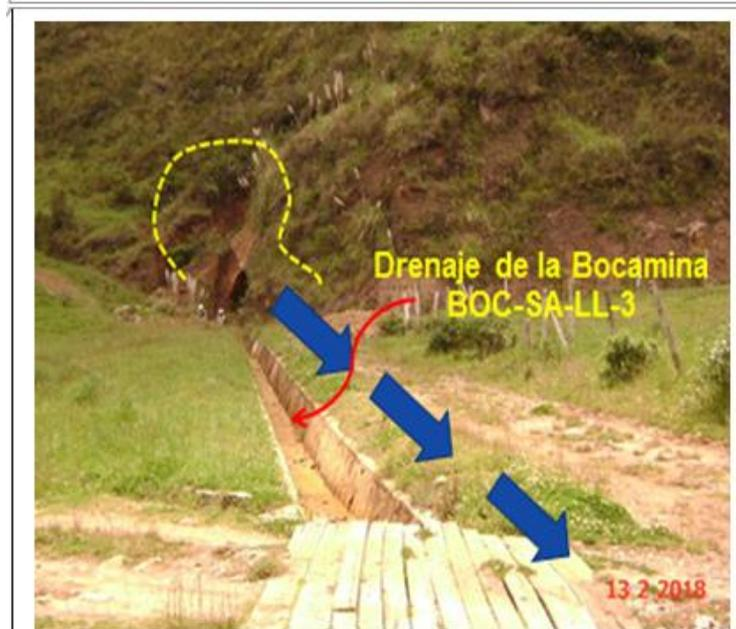
**Fotografía N° 44:** Se observa que el drenaje de la bocamina BOC-SA-LL-3, es conducido por un canal piedra y concreto, antes de su confluencia con el drenaje de la bocamina BOC-LO-LL-4.
