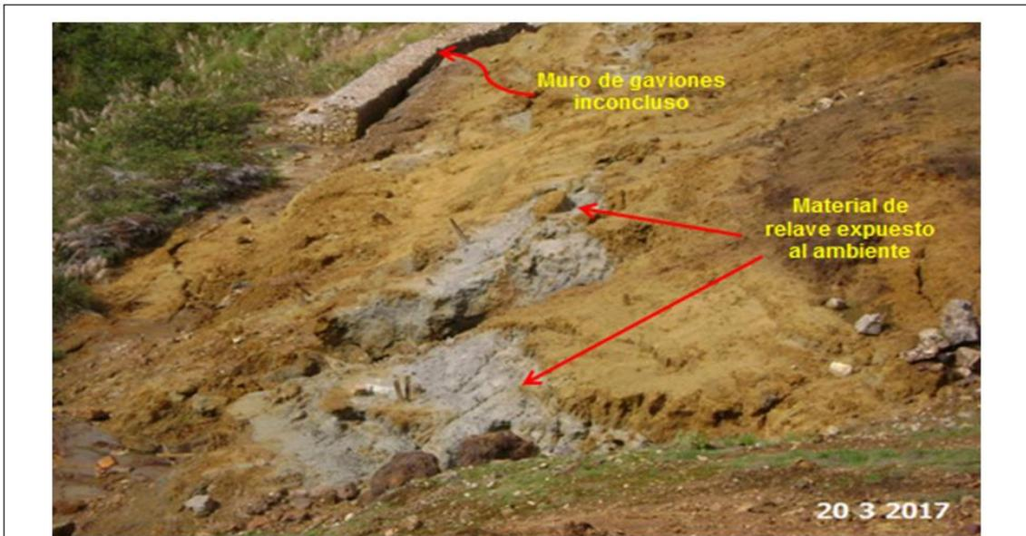
**Fotografía N° 80:** Vista cercana de un sector del pie del talud del depósito de relaves RELAV-MO-LL-4, se observa el material de relave expuesto al ambiente y el muro de gaviones inconcluso.
