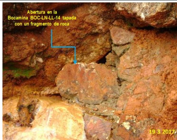
**Fotografía N° 19:** Abertura, en la parte superior del portal de la bocamina BOCLN-LL-14, que ha sido tapada con un fragmento de roca, pero por los bordes se observa el agua que sale del interior de esta bocamina.
