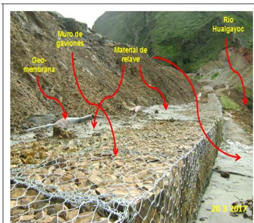
**Fotografía N° 76:** Muro de gaviones inconcluso ubicado al pie del depósito de relave RELAV-LM-LL-1, se observa material de relave sobre la parte superior y al pie de este muro.
