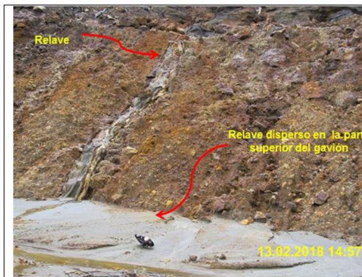
**Fotografía N° 95:** Vista cercana del material de relave ubicado sobre la parte superior del muro de gaviones del depósito de relave RELAV-LM-LL-1.
