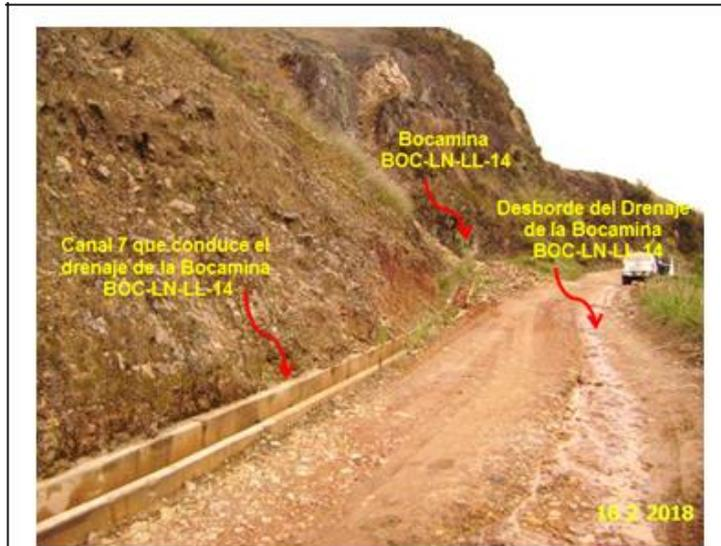
**Fotografía N° 57:** Drenaje de la bocamina BOC-LN-LL-14, que es conducido a través del Canal N° 7 de concreto, que va por el borde de la vía de acceso. Además, se observa, que el drenaje de la bocamina en mención, también discurre por la misma vía de acceso.
