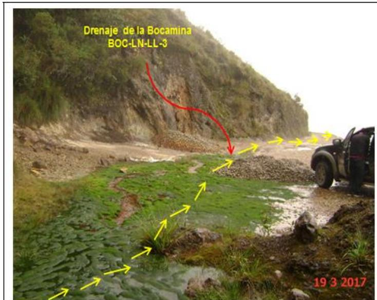
**Fotografía N° 15:** Drenaje de la bocamina BOC-LN-LL-3, ubicada en la zona Los Negros, se observa que este discurre por la vía de acceso, no existen estructuras hidráulicas.
