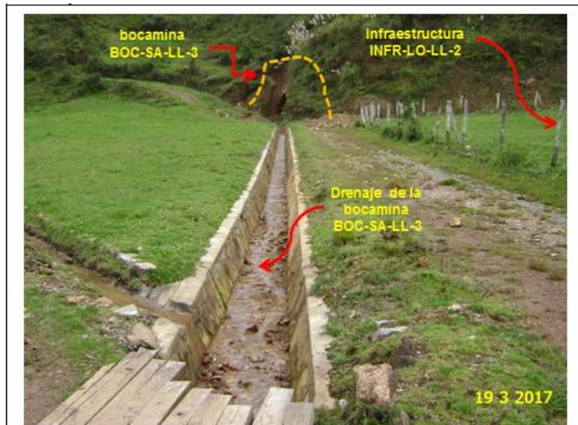
**Fotografía N° 10:** Se observa que el drenaje de la bocamina BOC-SA-LL-3, es conducido por un canal de piedra concreto, antes de su confluencia con el drenaje de la bocamina BOC-LO-LL-4.
