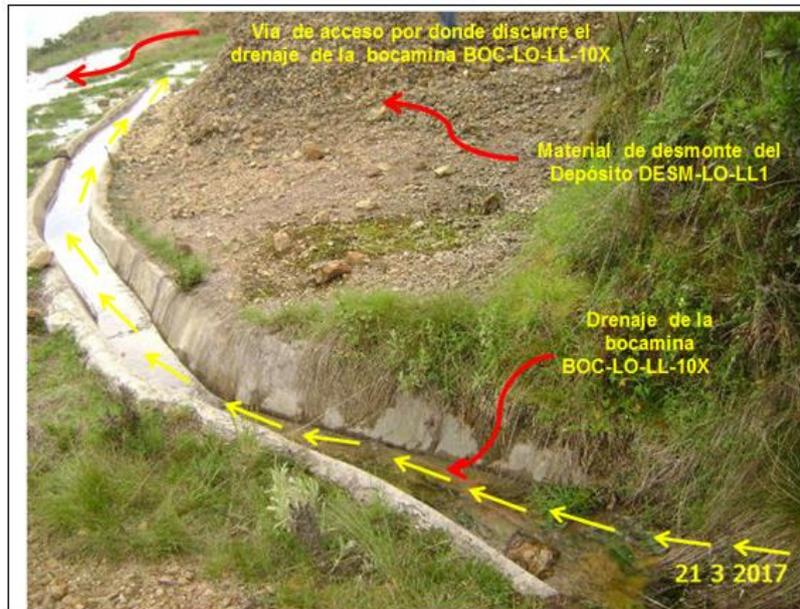
**Fotografía N° 3:** Canal de concreto que conduce el drenaje de la bocamina BOC-LO-LL-10X, por el borde de la desmontera DESM-LO-LL-1 y luego discurre por la vía de acceso.
