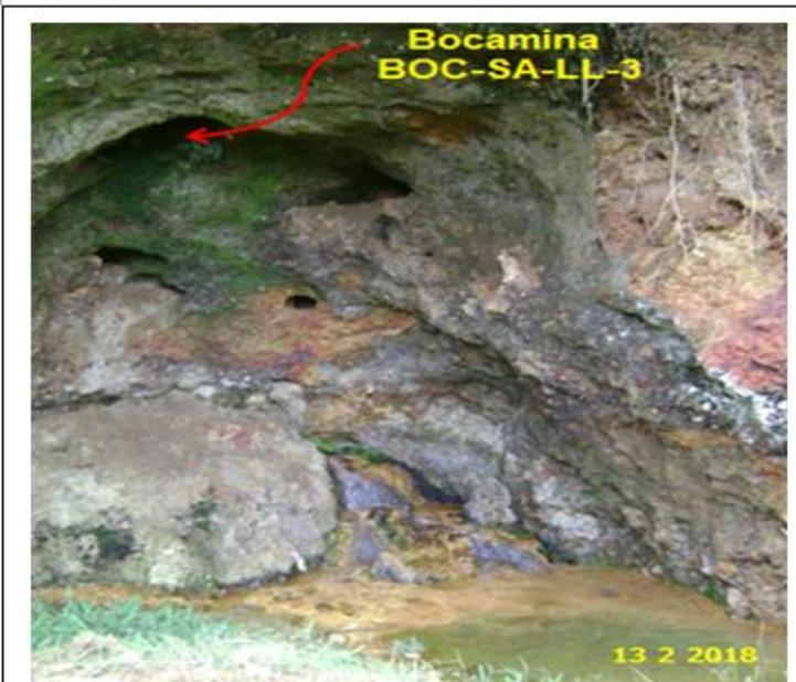
**Fotografía N° 42:** La bocamina BOC-SA-LL-3 se encuentra cerrada con un muro de material no identificado, el cual estaba cediendo debido a la infiltración y socavamiento del agua a través de las paredes de ésta, por la parte baja se observó un drenaje de mina que discurría por el suelo.
