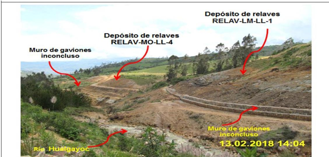
**Fotografía N° 98:** Los depósitos de relaves RELAV-LM-LL-1 y RELAV-MO-LL-4, se encuentran ubicados en el margen derecho del río Hualgayoc, en ambos componentes no se han realizado las actividades de cierre, puesto que presentan material de relave expuesto al ambiente, muro de gaviones inconclusos, y carece de estructuras hidráulicas. Se observa su cercanía al río Hualgayoc.
