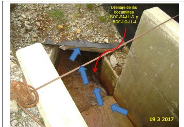
**Fotografía N° 13:** Los drenajes de las bocaminas BOC-SA-LL-3 y BOC-LO-LL-4, fluyen por medio de una alcantarilla de concreto, ubicado por debajo de la carretera asfaltada y luego salen por el otro extremo en dirección al río Hualgayoc
