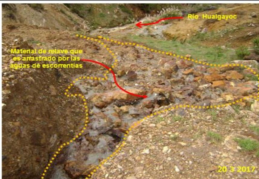
**Fotografía N° 73:** Vista del material de relave que siendo arrastrado por el agua de escorrentía fluye por el lado derecho del depósito de relaves RELAV-LM-LL-1 en dirección al río Hualgayoc.
