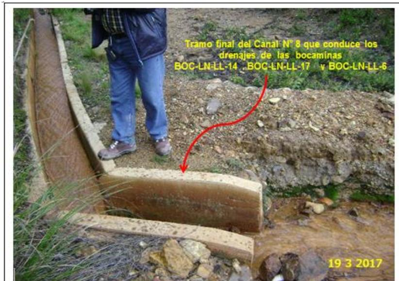
**Fotografía N° 30:** Zona donde termina el Canal N° 8, y los drenajes de las bocaminas BOC-LN-LL-14, BOC-LN-LL-17 y BOC-LN-LL-6 son descargado hacia una quebrada sin nombre.
