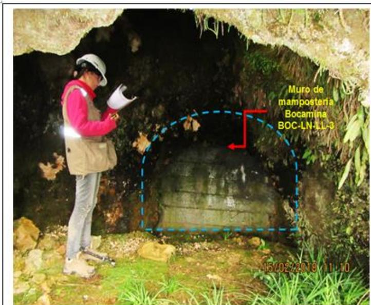
**Fotografía N° 48:** bocaminas BOC-LN-LL-3, ubicada en la zona Los Negros, cuenta con muro de mampostería, se observa vegetación delante de esta, no existen estructuras hidráulicas.
