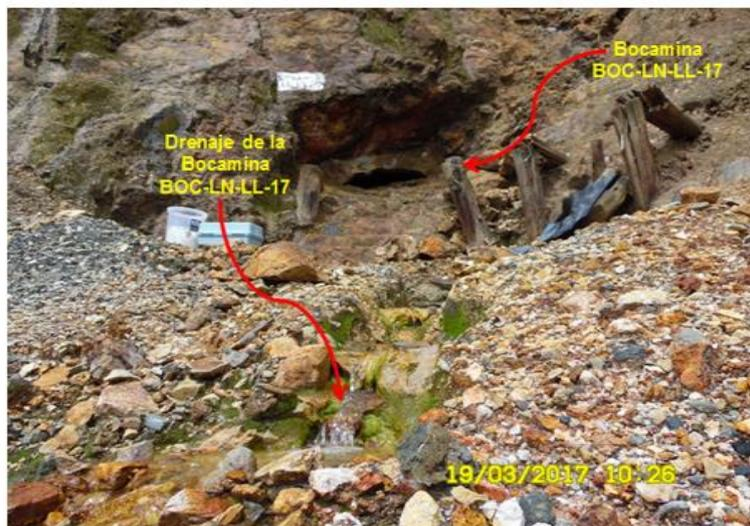
**Fotografía N° 24:** Bocamina BOC-LN-LL-17, su portal ha sido cerrado con muro de mampostería, sin embargo, presenta una abertura en la parte superior. Además, presenta drenaje que discurre sobre la desmontera DESM-LN-LL-11.
