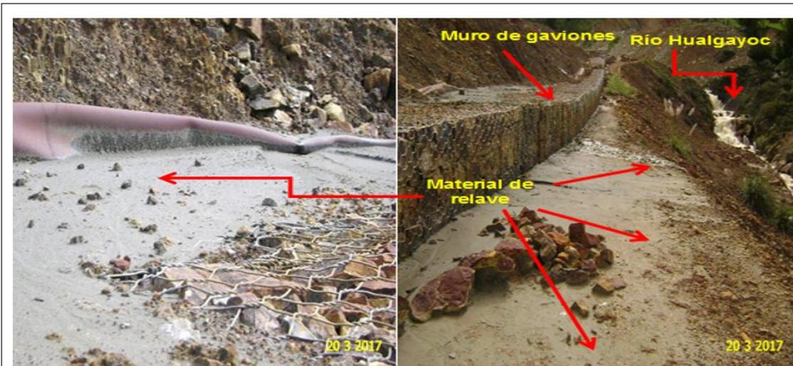
**Fotografía N° 74:** Material de relave sobre la parte superior y al pie del muro de gaviones del depósito de relave. RELAV-LM-LL-1, se observa su cercanía al río Hualgayoc.
