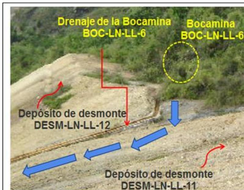
**Fotografía N° 66:** Efluente proveniente de la bocamina BOC-LN-LL-6, que va hacia del Canal N° 8 ubicado al pie del depósito de desmonte DESM-LN-LL-12, el cual conduce los drenajes de las bocaminas BOC-LN-LL-14, BOC-LN-LL-17 y BOC-LN-LL-6.
