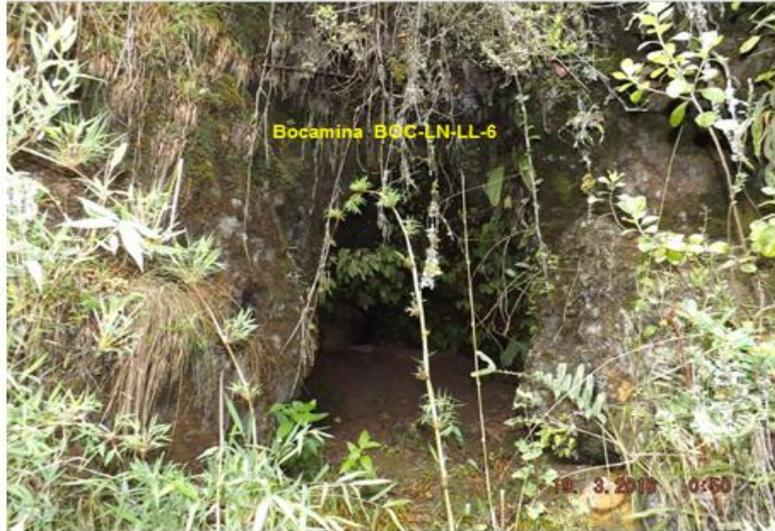
**Fotografía N° 26:** Bocamina BOC-LN-LL-6, ubicada en la zona Los Negros, con coordenadas UTM, (WGS 84) N: 9253491, E: 765382, se observa material de relleno cubriendo parte de su interior
