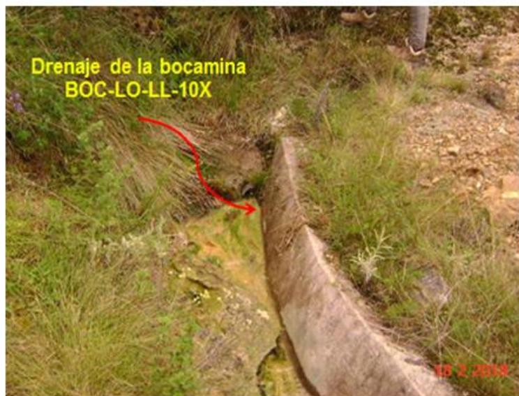
**Fotografía N° 33:** Cuneta ubicada al pie de la bocamina BOC-LO-LL-10X, por donde se descarga el efluente proveniente de la misma, ubicada en coordenadas UTM (WGS 84), E: 767530, N: 9252045 Zona 17 S.
