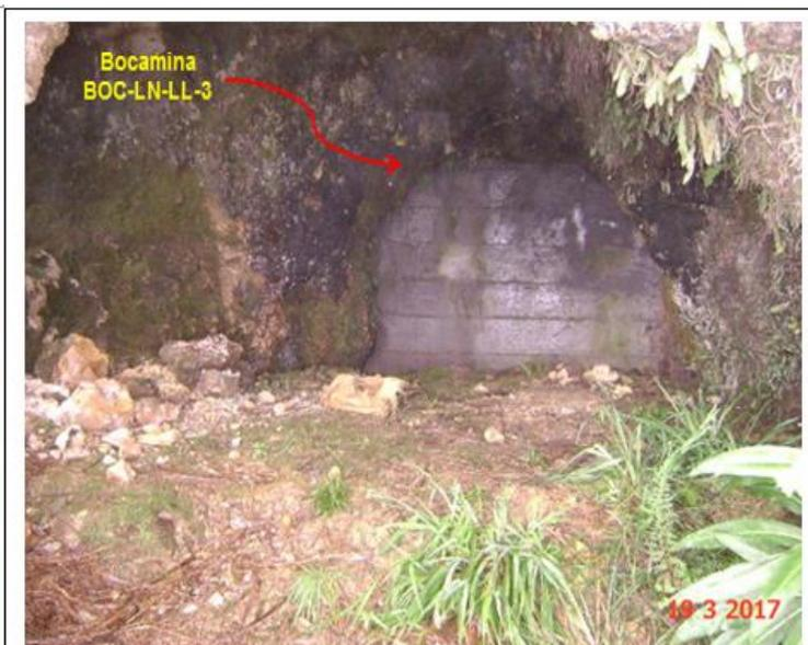
**Fotografía N° 14:** bocaminas BOC-LN-LL-3, ubicada en la zona Los Negros, cuenta con muro de mampostería, se observa vegetación delante de esta, no existen estructuras hidráulicas.
