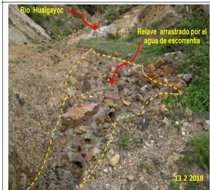
**Fotografía N° 94:** Otra Vista del material de relave que está siendo arrastrado por el agua de escorrentía que fluye por el lado derecho del depósito de relaves RELAV-LM-LL-1 en dirección al río Hualgayoc.
