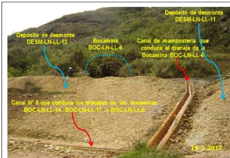
**Fotografía N° 28:** Descarga final proveniente de la bocamina BOC-LO-LL-6, que es conducido por un canal de mampostería y luego se une con el Canal N° 8.
