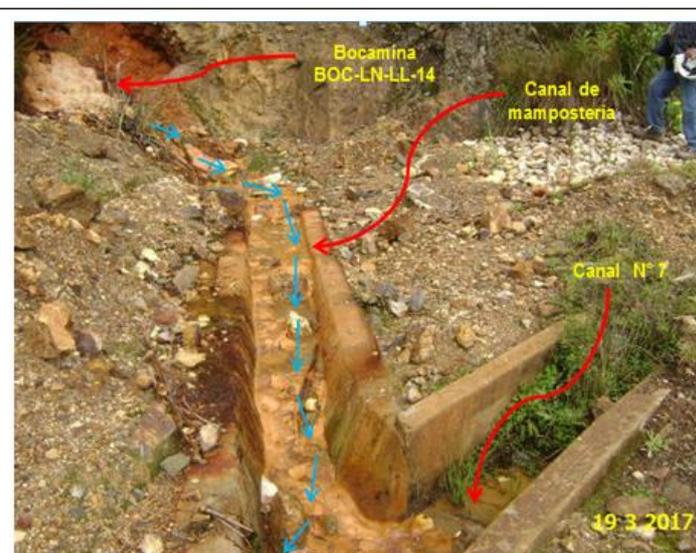
**Fotografía N° 20:** Bocamina BOCLN-LL-14, cerrada con piedra y concreto, tiene una abertura, en la parte superior, que ha sido tapada con fragmento de roca, pero por sus bordes discurre agua del interior de esta bocamina, que llega hasta el suelo, y luego es conducido por un canal de mampostería, para unirse con el Canal N° 7.
