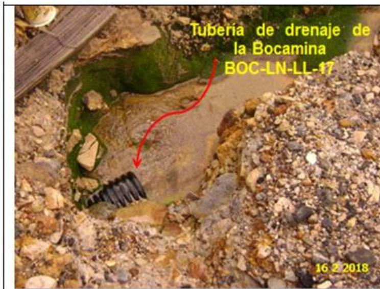
**Fotografía N° 60:** Tubería por donde sale drenaje de la bocamina BOC-LN-LL-17, que discurre por el depósito de desmonte DESM-LN-LL-11.
