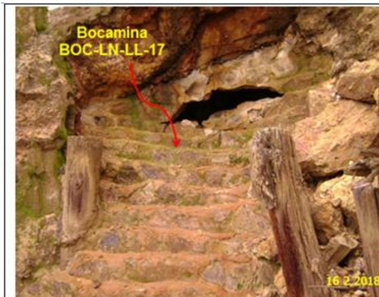
**Fotografía N° 58:** Bocamina BOC-LN-LL-17, su portal ha sido cerrado con muro de mampostería, sin embargo, presenta una abertura en la parte superior.
