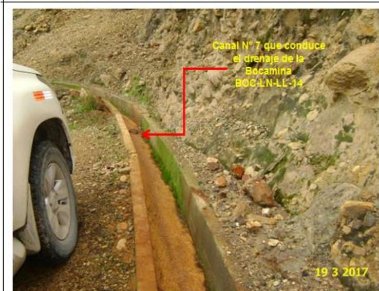
**Fotografía N° 21:** Drenaje de la bocamina BOC-LN-LL-14, que es conducido a través del Canal N° 7 de concreto.
