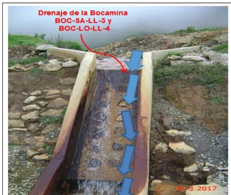
**Fotografía N° 12:** Drenaje de las bocaminas BOC-LO-LL-4 y BOC-SA-LL-3., que se dirigen en dirección a la carretera asfaltada, a través de un canal de piedra y concretas.
