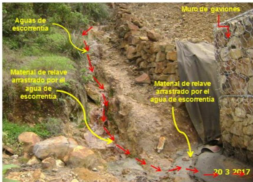
**Fotografía N° 71:** Agua de escorrentía que discurre por el lado derecho del depósito de relave RELAV-LM-LL-1, y arrastra el material de relave.
