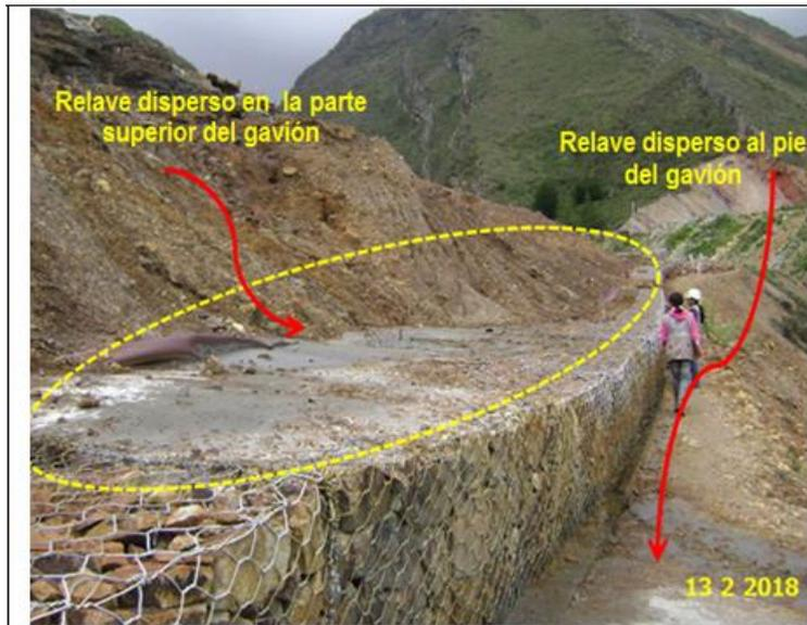
**Fotografía N° 96:** Muro de gaviones inconcluso ubicado al pie del depósito de relave RELAV-LM-LL-1, se observa material de relave sobre la parte superior y al pie de este muro de gaviones.
