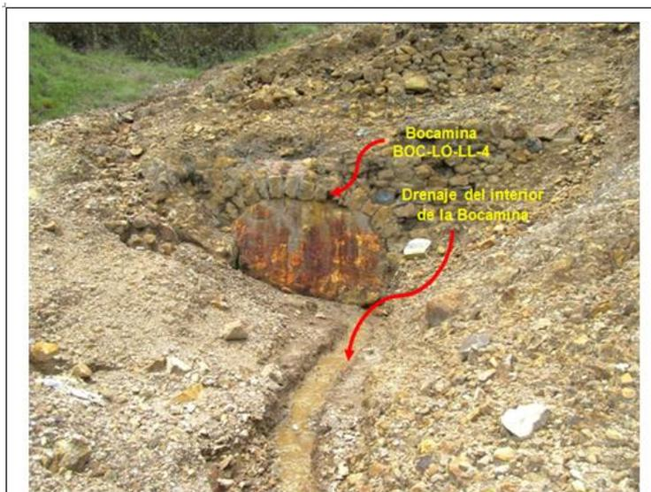
**Fotografía N° 38:** Bocamina BOC-LO-LL-4, se observa el portal cerrado con piedra y concreto y drenaje de mina al pie de este componente que fluye por un primer tramo por el canal de piedra y concreto.
