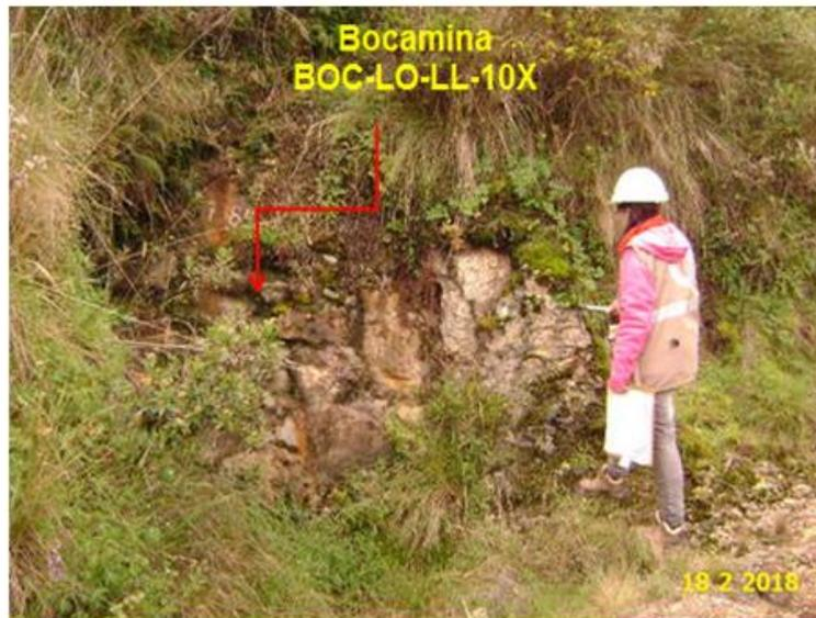
**Fotografía N° 32:** Bocamina BOC-LO-LL-10X, ubicada en la zona Lola en coordenadas (UTM WGS 84), N: 9252045, E: 767530, el portal se encuentra cerrada con piedra y concreto.
