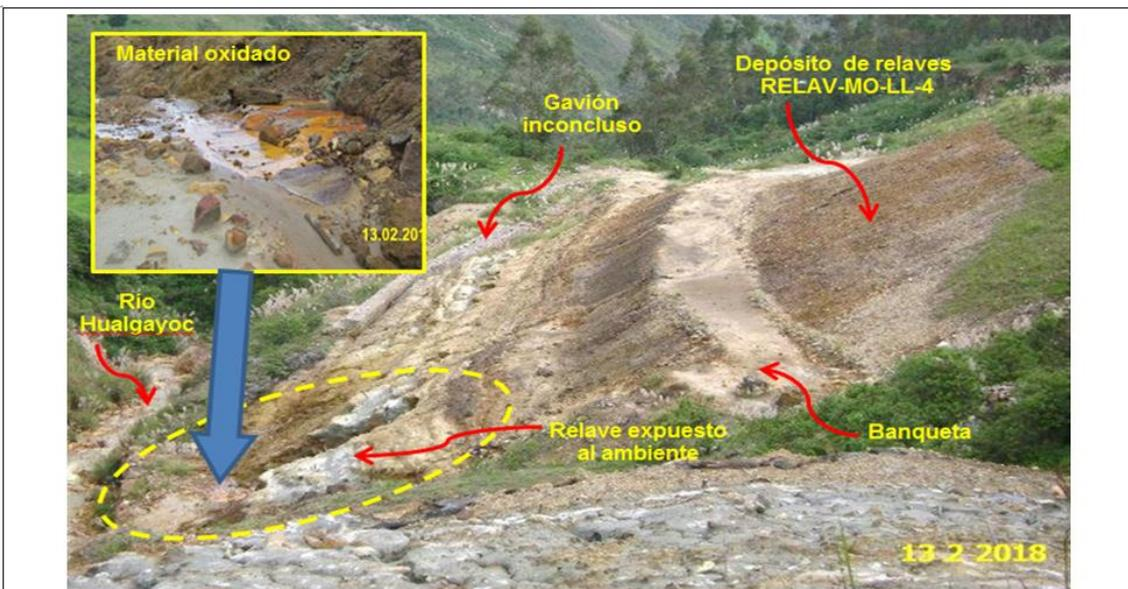
**Fotografía N° 99:** Vista del depósito de relaves RELAV-MO-LL-4, ubicado en la zona Los Negros en coordenadas (UTM WGS 84), N: 9253261, E: 766685. con material expuesto, conformado por una banqueta y un muro de gaviones inconcluso. Además, se observa la formación de material oxidado al pie del talud de este, así como su cercanía al río Hualgayoc.
