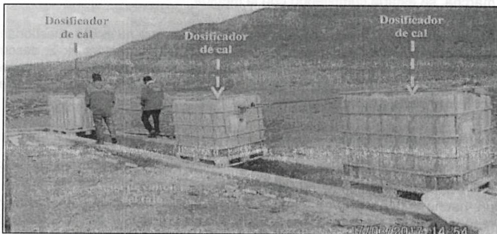
Fotografía N° 23 – Sistema de tratamiento de agua colectada del tajo; El agua de contacto del Tajo Huisamarca es dosificada con cal de forma manual, mediante tres dosificadores de cal instalados en serie; para luego ser derivada a las tres pozas de sedimentación.
