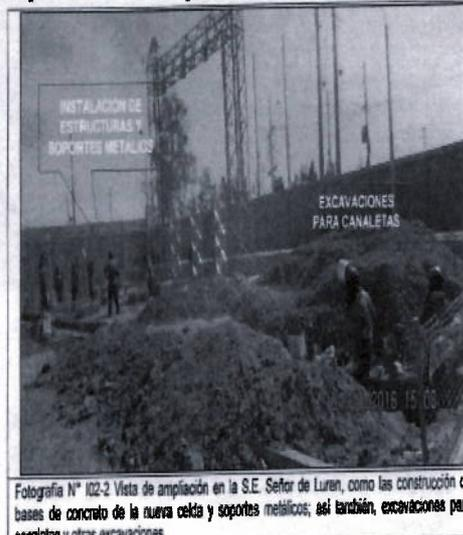
Fotografía N° 102-2 Vista de ampliación en la S.E. Señor de Luren, como la construcción de bases de concreto de la nueva celda y soportes metálicos; así también, excavaciones para canaletas y otras excavaciones.
