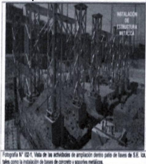
Fotografía N° 102-1. Vista de las actividades de ampliación dentro del patio de llaves de S.E. Ica, tales como la instalación de bases de concreto y soportes metálicos.
