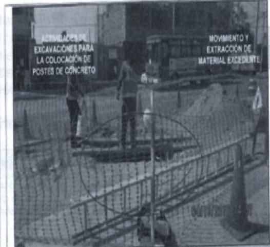
Fotografía N° 102-4. Vista de trabajos y excavaciones para la colocación de postes de la nueva L.T. 60 kV, movimiento y extracción de material excedente.
