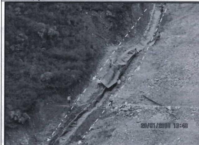
**Fotografía N° 18.** Vista de la colocación de geomembrana en el Canal de Perimetral 1C Tramo 2 que había sido erosionado.
