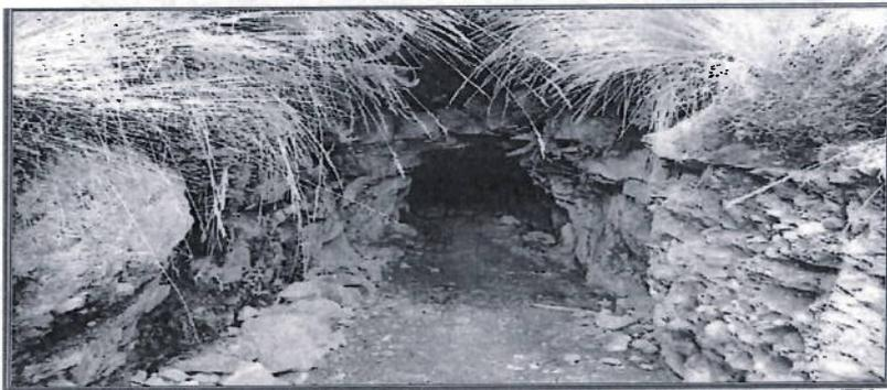
Fotografía N° 4: Zona San Salvador: Bocamina ubicada en las coordenadas UTM WGS 84: 227904E y 8914758N. Se constató que no se realizó las actividades propuestas en el plan de cierre de los pasivos ambientales mineros de la unidad minera Lincuna Tres. (Acta de Supervisión – Componentes verificados, ítem 7).
