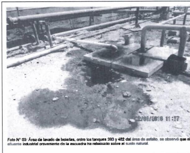
Foto N° 03: Área de lavado de botellas, entre los tanques 393 y 482 del área de asfalto, se observó que el efluente industrial proveniente de la escuadra ha rebalsado sobre el suelo natural.
