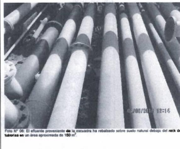
Foto N° 06: El efluente proveniente de la escuadra ha rebalsado sobre suelo natural debajo del rack de tuberías en un área aproximada de 150 m².
