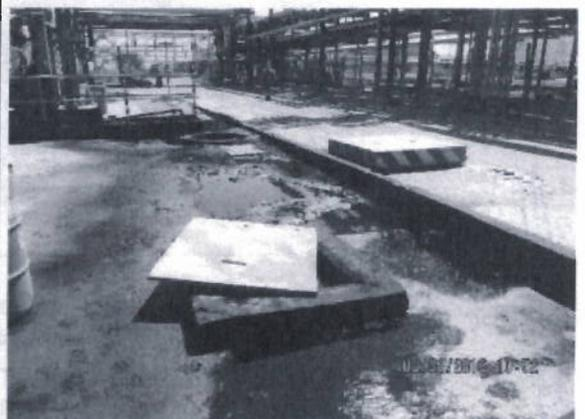
Foto N° 02: El efluente industrial proveniente de la escuadra ha rebalsado sobre el suelo natural en un área aproximada de 80 m<sup>2</sup>.
