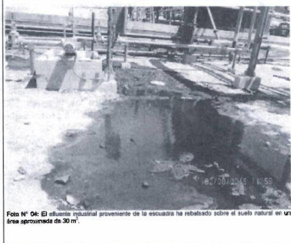
Foto N° 04: El efluente industrial proveniente de la escuadra ha rebalsado sobre el suelo natural en un área aproximada de 30 m².
