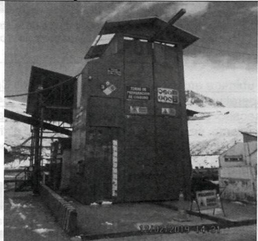
Fotografía N° 17: Vista de la torre de preparación de cianuro que marcaba un nivel de 100 % de su capacidad.
