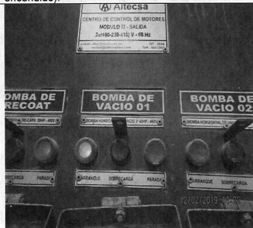
Fotografía N° 9: Vista del tablero de control de la bomba de vacío 01 (botón verde encendido).
