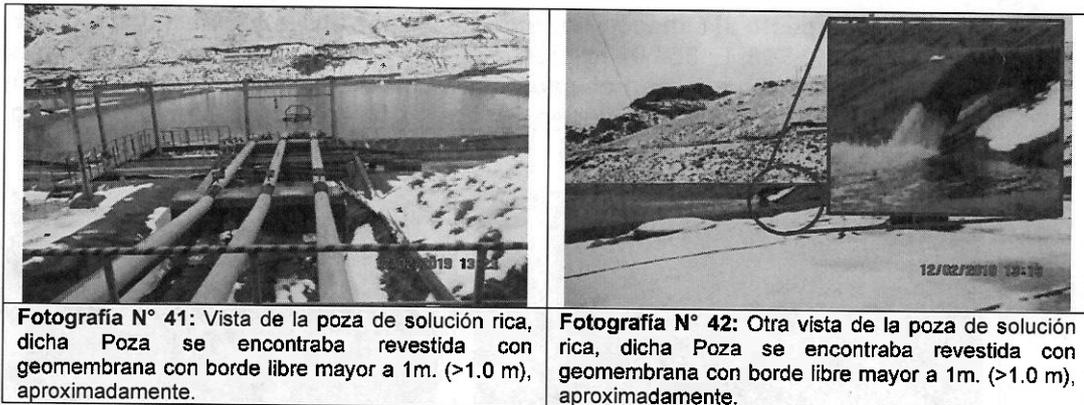
**Fotografía N° 41:** Vista de la poza de solución rica, dicha Poza se encontraba revestida con geomembrana con borde libre mayor a 1m. (>1.0 m), aproximadamente.
