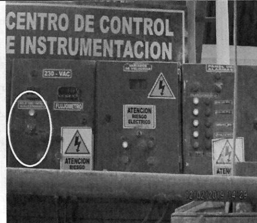
Fotografía N° 11: Vista del tablero de control del nivel de torre de vacío y control de válvula electroneumática (botón verde encendido).
