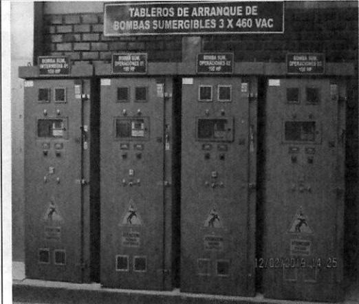
Fotografía N° 12: Vista de los tableros de arranque de bombas sumergibles 3 x 460 VAC (botón verde encendido).
