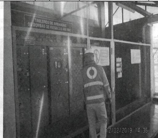
Fotografía N° 15: Vista del tablero de control de las bombas de riego 3 x 460 VAC.
