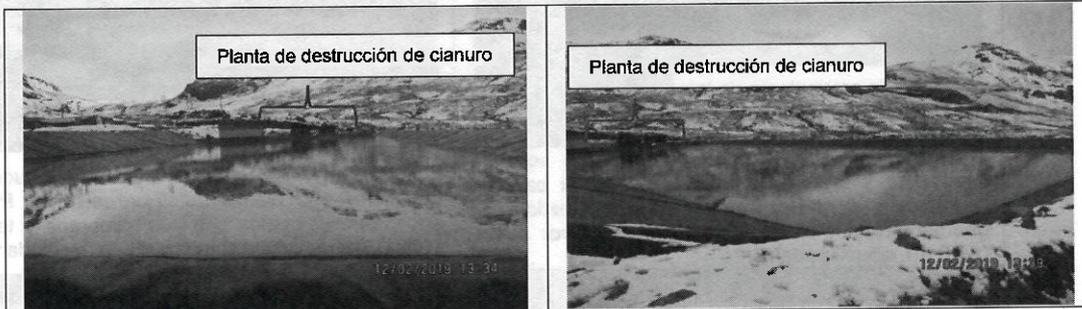
**Fotografía N° 39:** Vista de la poza de grandes eventos adyacente a la planta de destrucción de cianuro, dicha Poza se encontraba revestida con geomembrana con borde libre mayor a 1m. (>1.0 m), aproximadamente.
