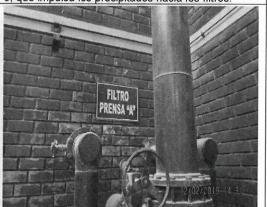
Fotografía N° 6: Vista del sistema de conducción de los precipitados hacia el filtro prensa "A", ubicado en el área de refinería.
