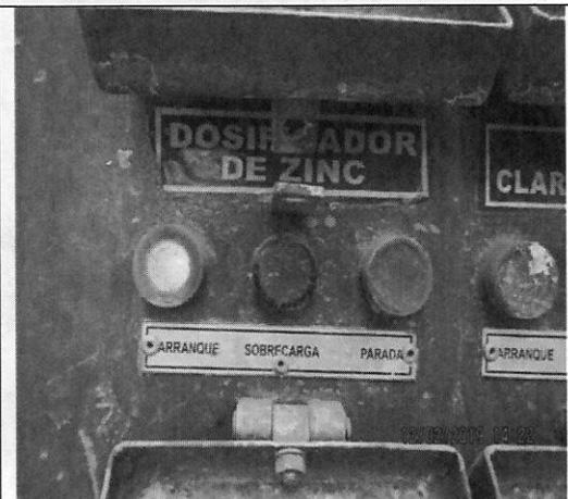
Fotografía N° 10: Vista del tablero de control del dosificador de zinc (botón de arranque encendido).
