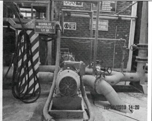
Fotografía N° 4: Vista de la bomba de precipitado N° 3, que impulsa los precipitados hacia los filtros.
