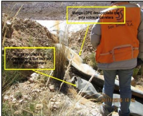
Fotografía N° 39: Vista del paso de manga LDPE y tubería HDPE que se encuentran direccionadas a la acumulación de solución pregnant.
