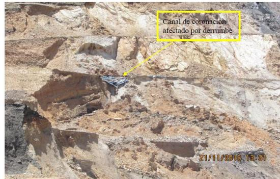
Fotografía N° 31: Vista del canal de coronación del tajo Suro sur, se observa que ha sido afectado por el deslizamiento de material de las paredes del tajo.
