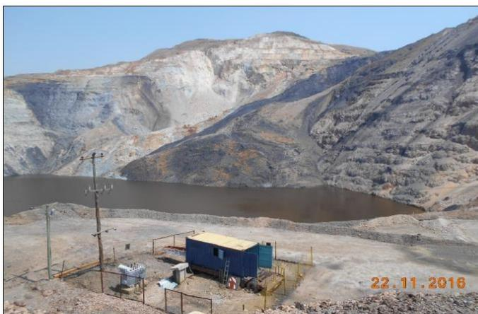
Fotografía N° 108: Punto de muestreo ESP-6: Infiltración proveniente del Tajo Suro Sur, ubicado en el vaso del Tajo con coordenadas (Datum WGS-84) E: 821428, N: 9117330. Obsérvese no hay presencia de subdrenaje fue cubierto por el derrumbe.
