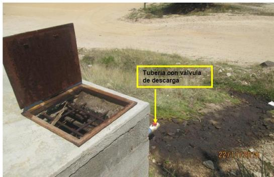
Fotografía N° 66: Vista de la salida del cajón de la trampa de grasa, compuesta por una tubería de PVC y una válvula de descarga. Aguas abajo se observa agua oleosa derramada sobre el suelo.
