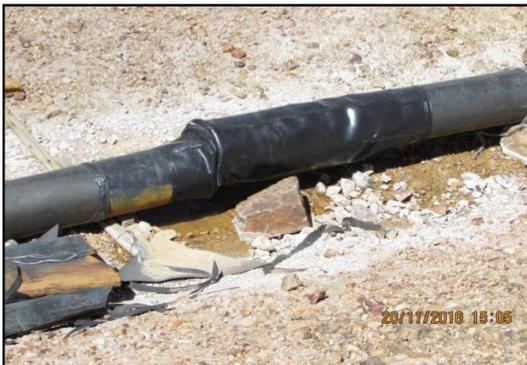
Fotografía N° 48: Vista del segundo empalme entre dos tuberías HDPE, realizada envuelta con geomembrana. Presenta solución pregnant en el suelo.
