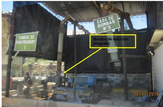
Fotografía N° 56: Vista de la casa de bombas N° 3, en el interior la bomba que envi solución pregnant a la planta ADR.
