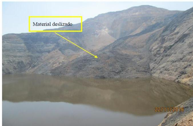
Fotografía N° 21: Vista del derrumbe ocurrido en el tajo Suro sur.
