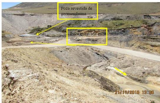
Fotografía N° 32: Vista de la parte superior del tajo Suro sur, se ubican dos pozas una revestida con geomembrana y la otra excavada en suelo, ambas direccionadas hacia el tajo Suro sur.
