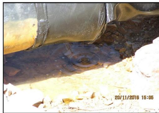
Fotografía N° 49: Vista del goteo del empalme de las dos tuberías HDPE.
