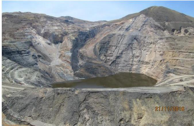
Fotografía N° 20: Vista del tajo Suro sur, se observó que las paredes han sufrido un deslizamiento, encontrándose acumulación de agua en el interior del vaso.
