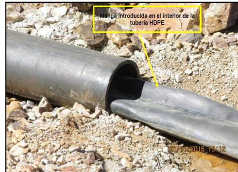
Fotografía N° 44: Vista del ingreso de la manga LDPE hacia la tubería HDPE y en el suelo solución pregnant.
