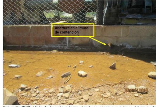
Fotografía N° 58: Vista de la parte externa, donde se observa que fuera del muro de contención se encuentra solución derramada sobre el suelo, inclusive existe una abertura en el muro.
