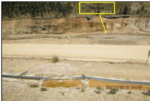
Fotografía N° 42: Vista de acumulación de solución sobre el suelo, debajo de la manga LDPE. Se aprecia aproximadamente a 30 m el río Suro.
