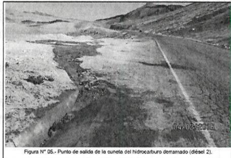
Figura N° 05.- Punto de salida de la cuneta del hidrocarburo derramado (diésel 2).
